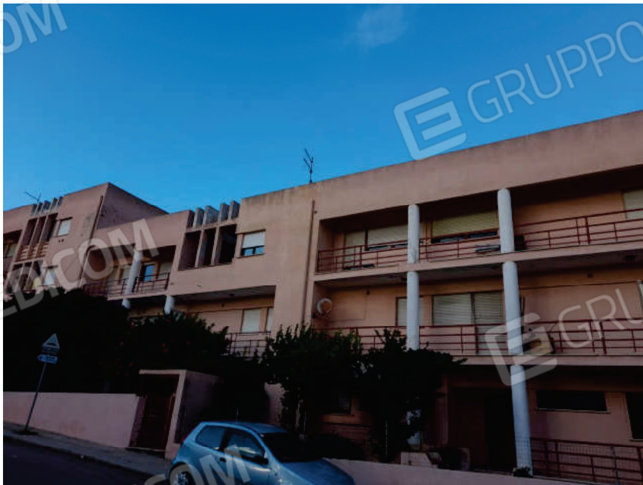
Foto 4: Vista Esterno piano 2° su Via Lu Calteri
