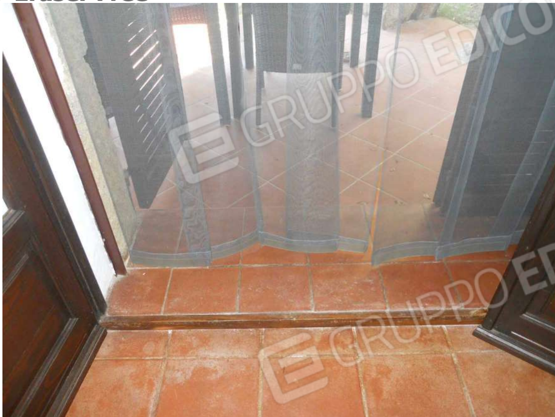
Foto 21: particolare delle soglie di ingresso.
