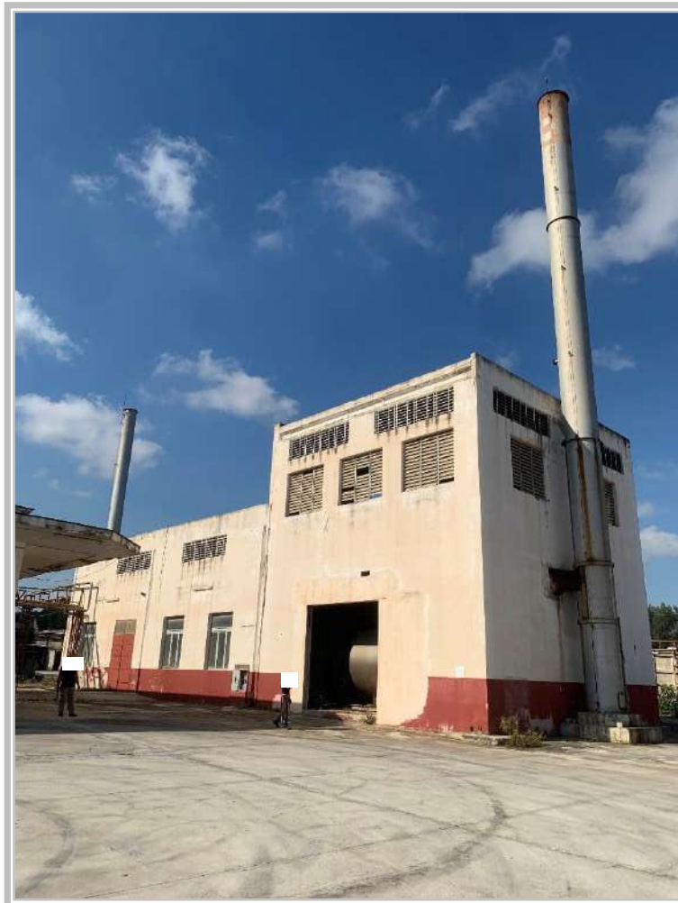
Foto n. 12 : Lotto 9 – Locale caldaie
