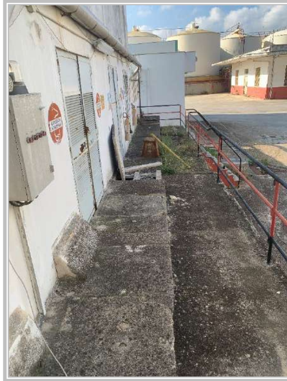
Foto n. 9 : Lotto 6 – Cabina ENEL Trasformatori
