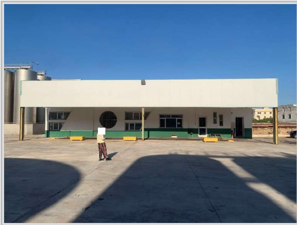
Foto n. 10 : Lotto 7 – Uffici di movimentazione
