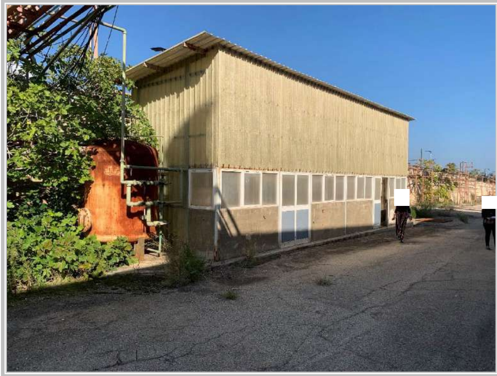
Foto n. 11 : Lotto 8 – Locale impianto addolcimento acque.
