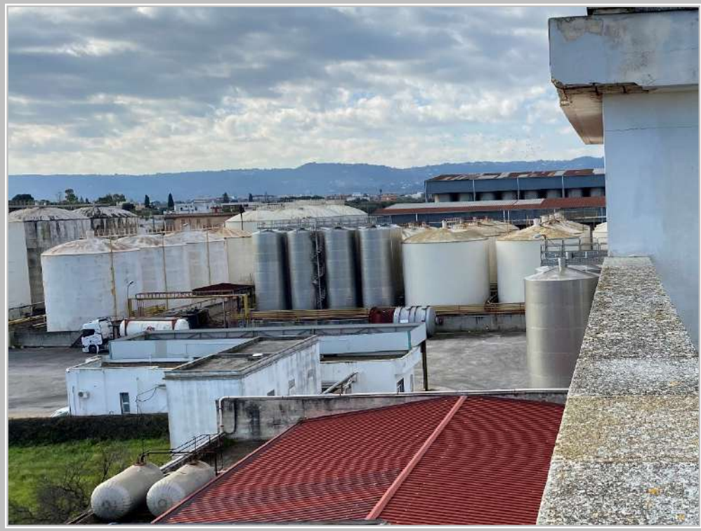
Foto n. 20: Parco serbatoi scoperto
