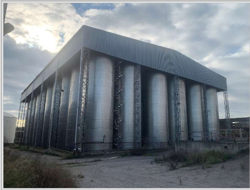
Foto n. 19 : Parco serbatoi coperti
