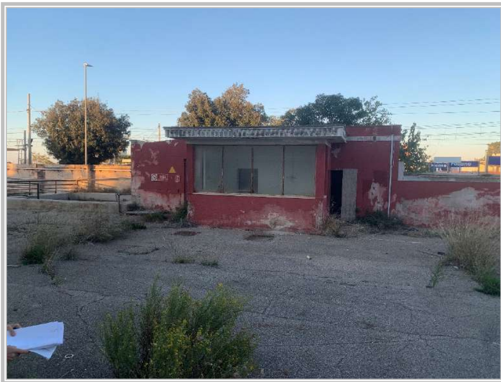
Foto n. 3: Lotto 1 - Gabbiotto portineria
