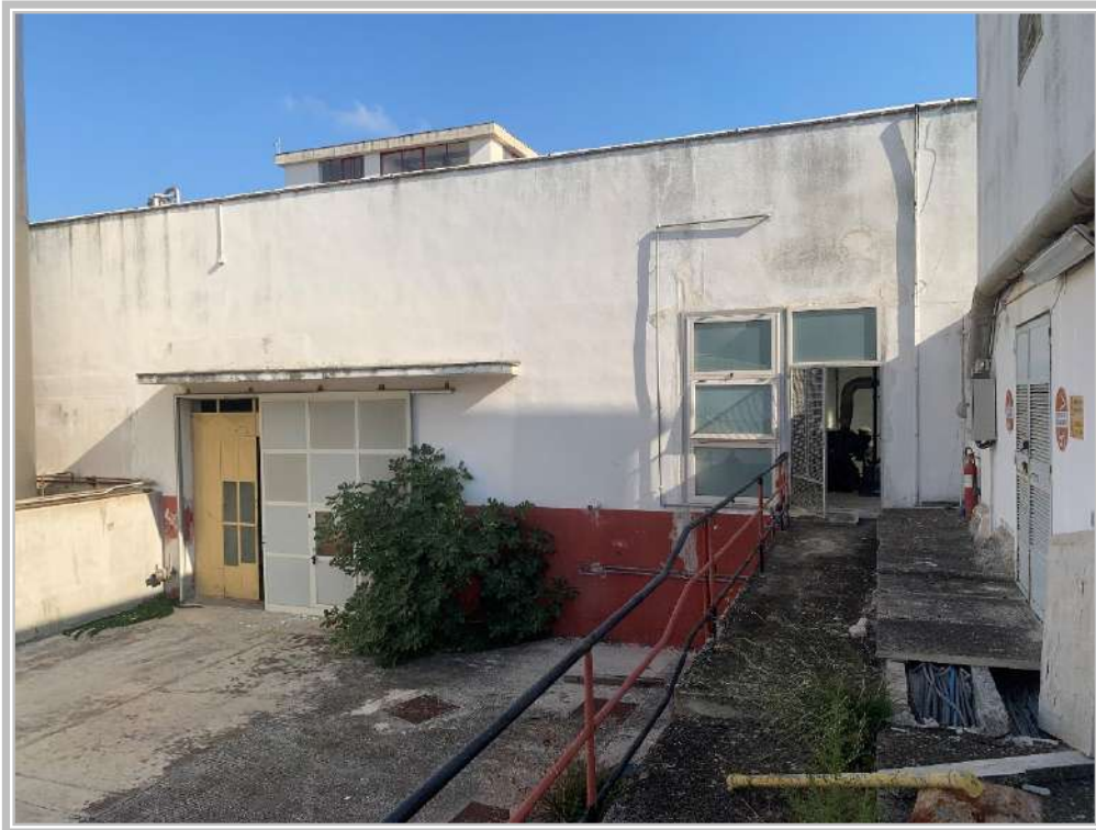
Foto n. 18 : Lotto 15 – Quadri elettrici gruppo elettrogeno
