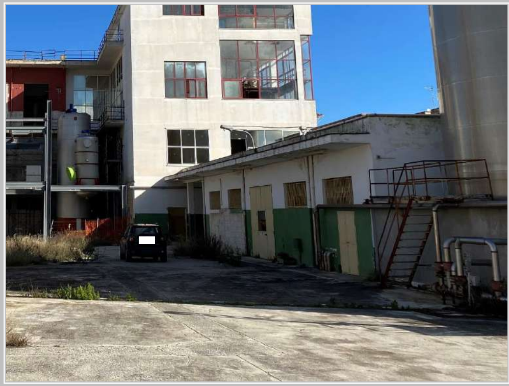
Foto n. 17 : Lotto 14 – Magazzino “Olio vergine e olio extra”
