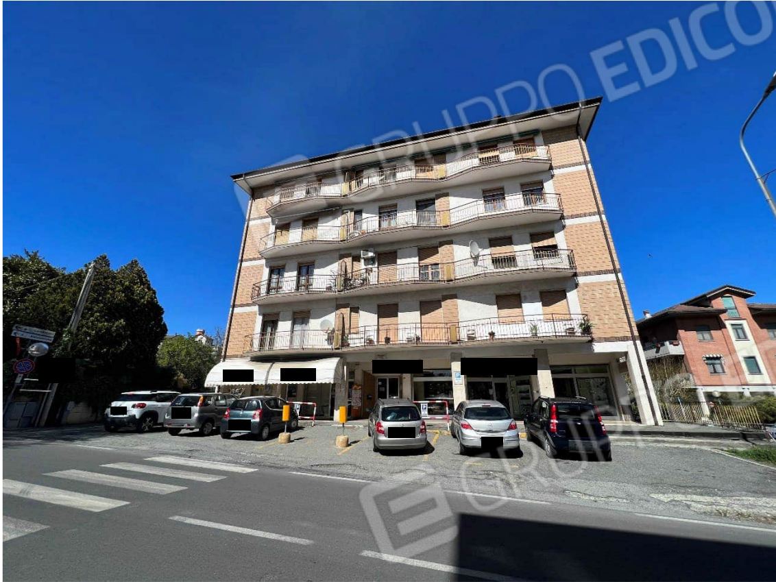
Figura 1 vista stabile condominiale
