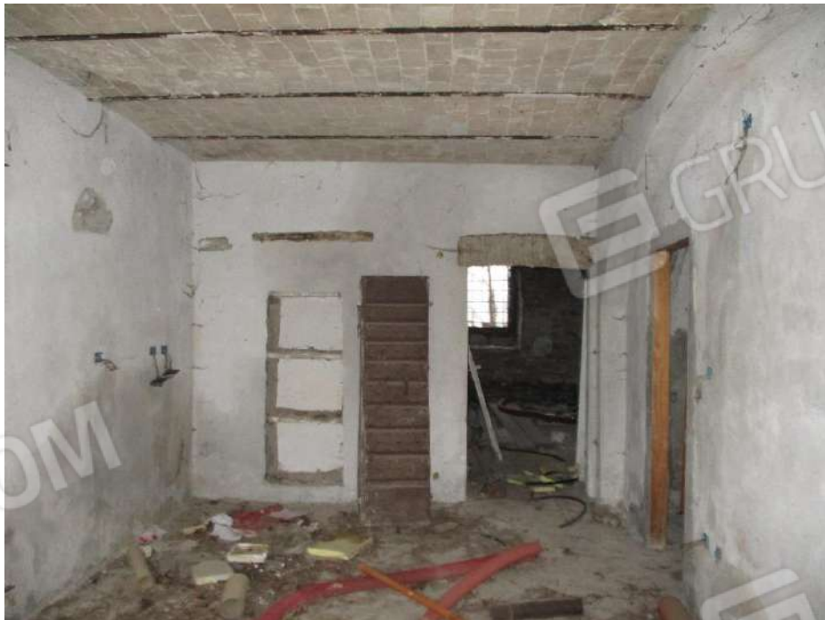
Locale di sgombero e cantina al piano primo seminterrato
