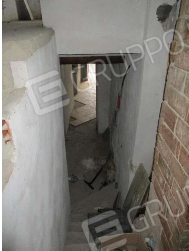
Scala di accesso al primo piano sottotetto
