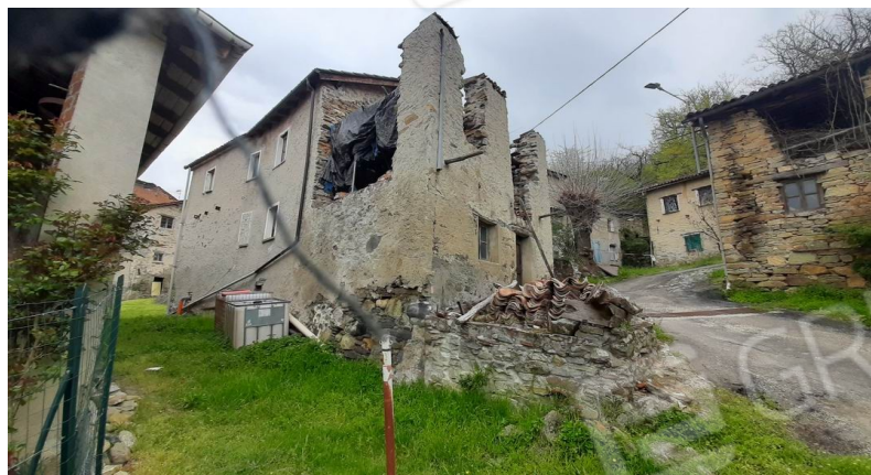
lo scorcio del retro e la testata sud del fabbricato sul lato di arrivo
