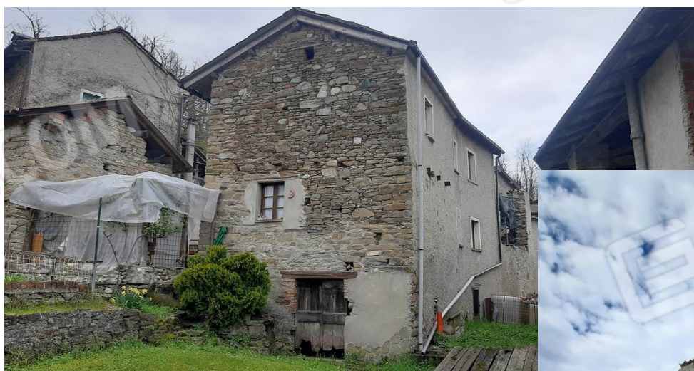
la testata nord
