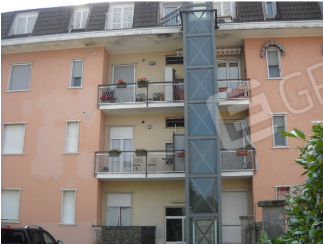
Prospetto condominiale verso strada
