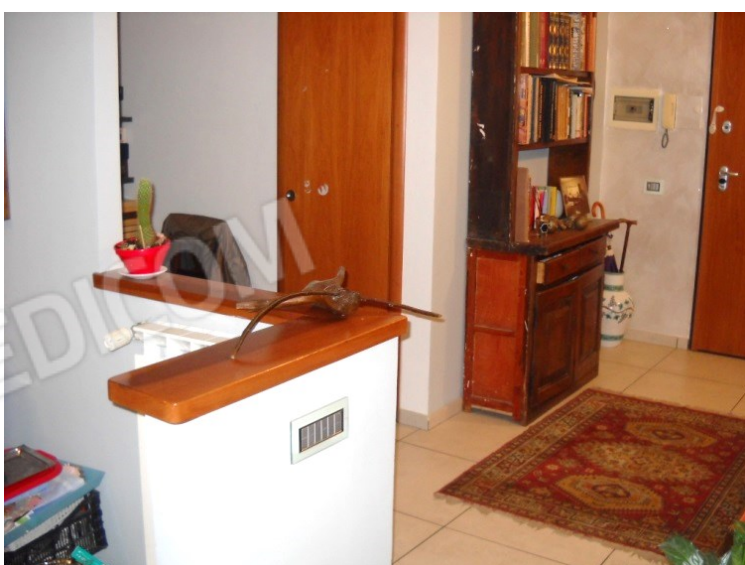
Tramezza rimossa zona cucina
