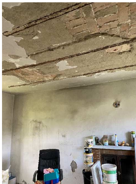
al piano terreno
