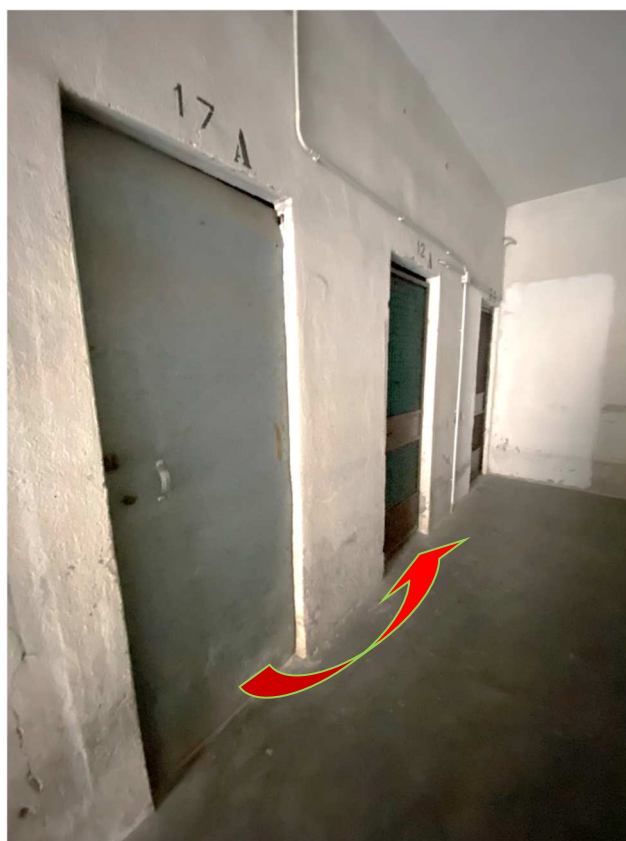
indicazione della cantina 12A
