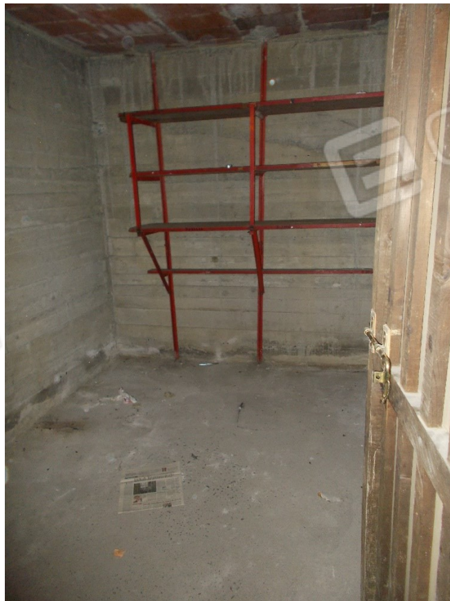
6. Particolare interno - cantina
