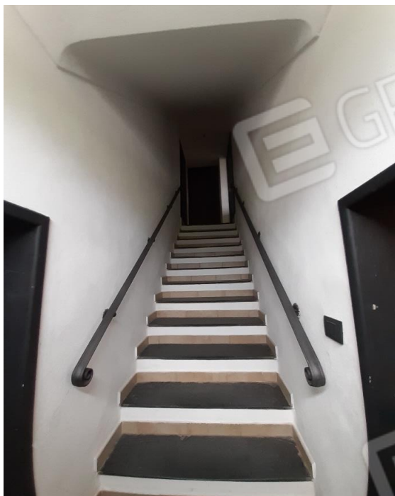
Scala a rampa unica
