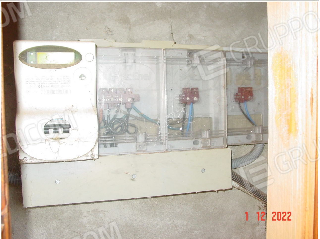
Particolare nicchia contatori energia elettrica
