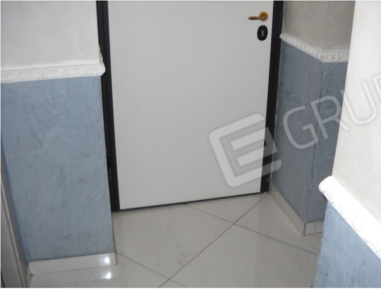
Ingresso piano terreno
