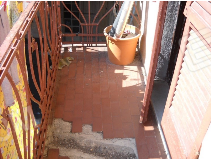
Balcone piano primo (lato cortile)
