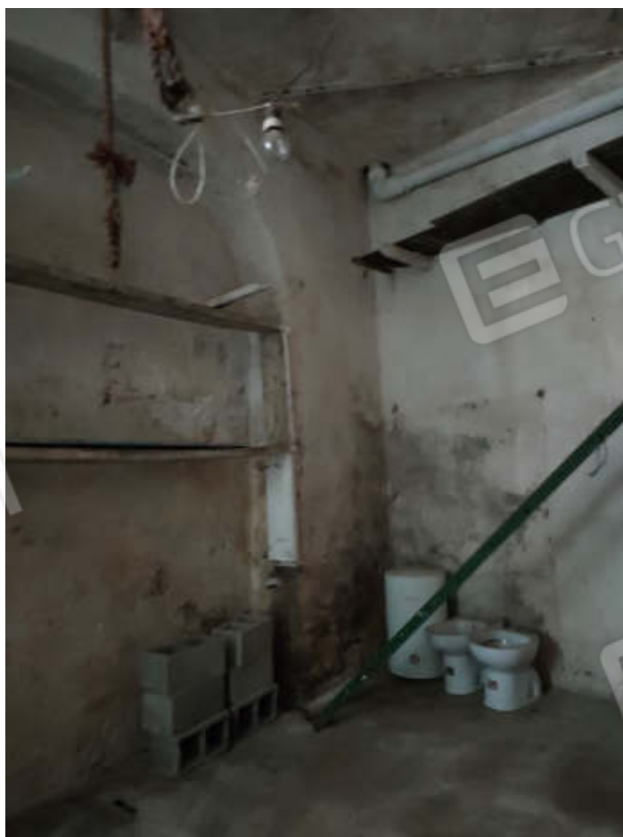
Vista interna rifiniture locale cantina e soppalco
