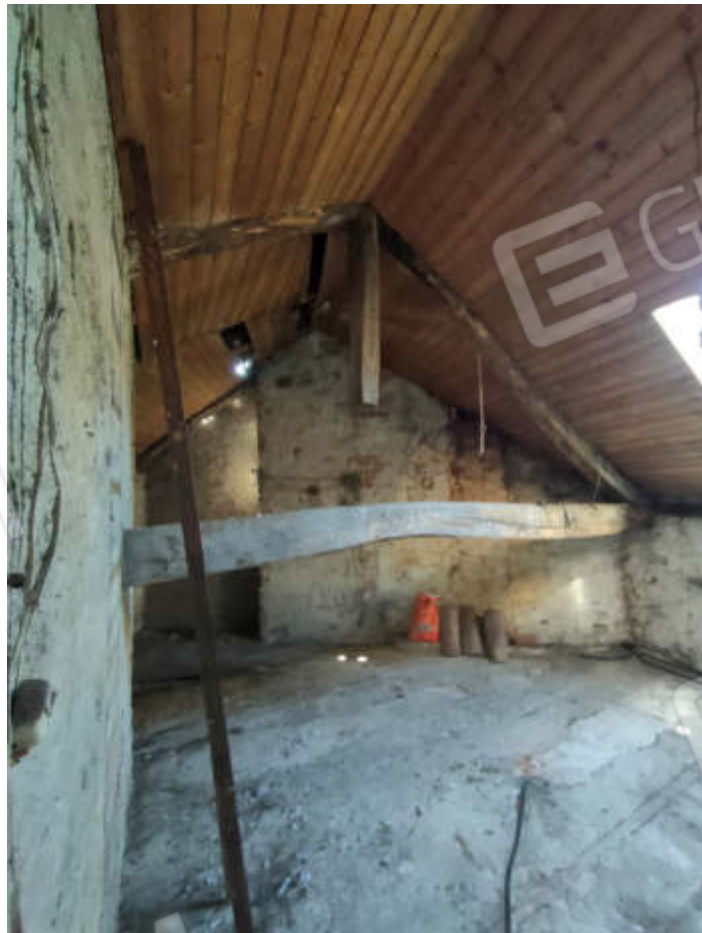
Vista interna rifiniture locale solaio in piano terzo – sottotetto
