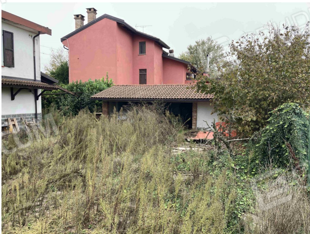
Foto 6 – Cortile sul retro
