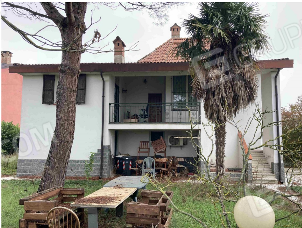
Foto 2 – Prospetto principale (sud)
