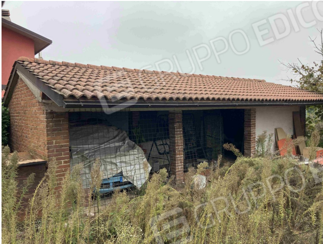
Foto 7 – Fabbricato ad uso deposito
