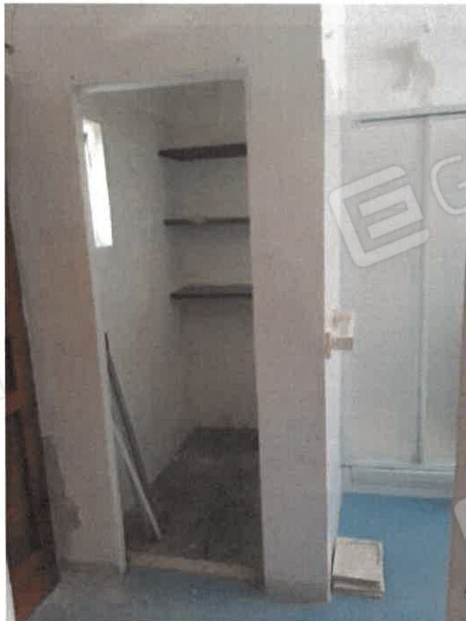
Visa interna del piccolo locale ripostiglio pertinenziale
