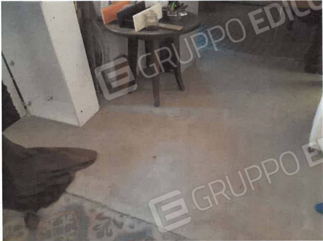
Ripristino porzione di pavimentazione in battuto di Cls
