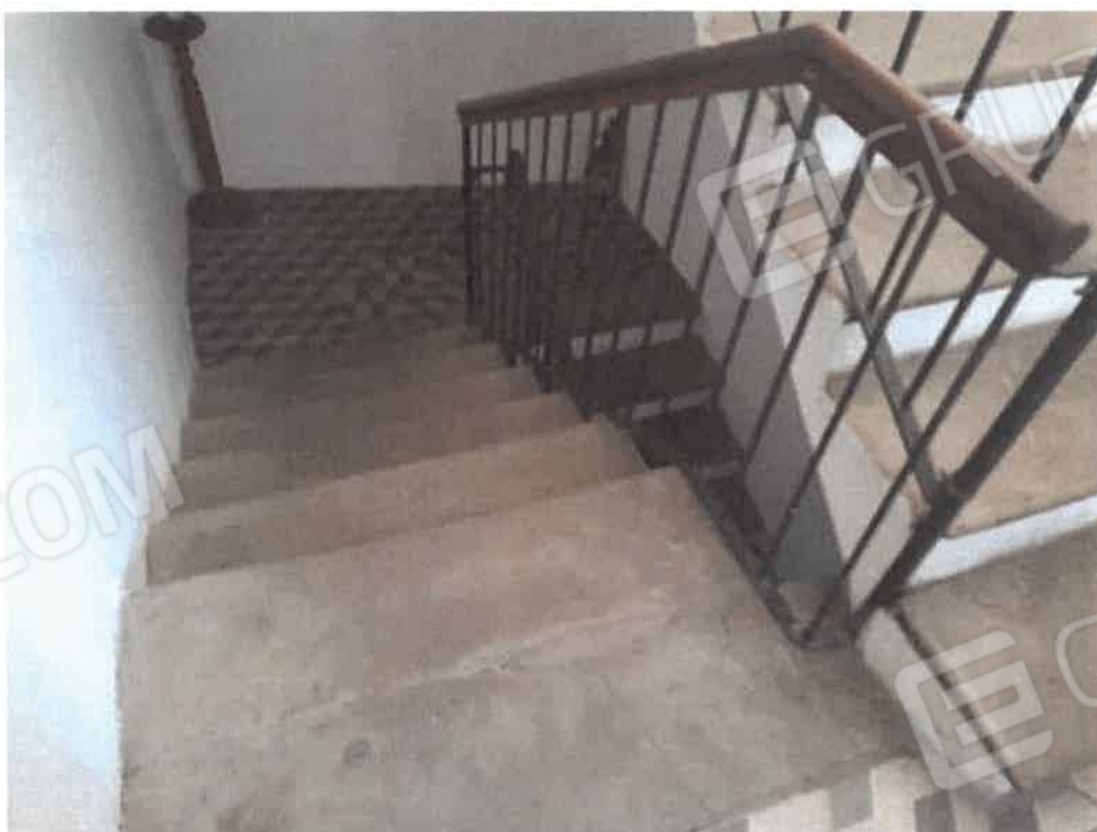
Vista interna del vano scala comune di accesso ai piani
