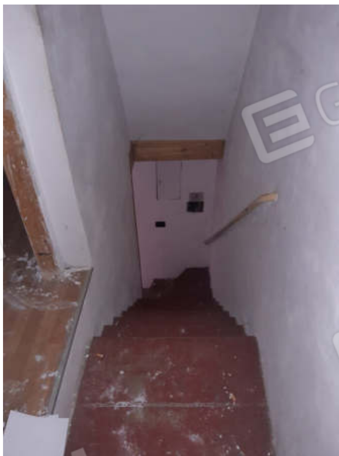
Vista interna del vano scala di collegamento piano terra / primo
