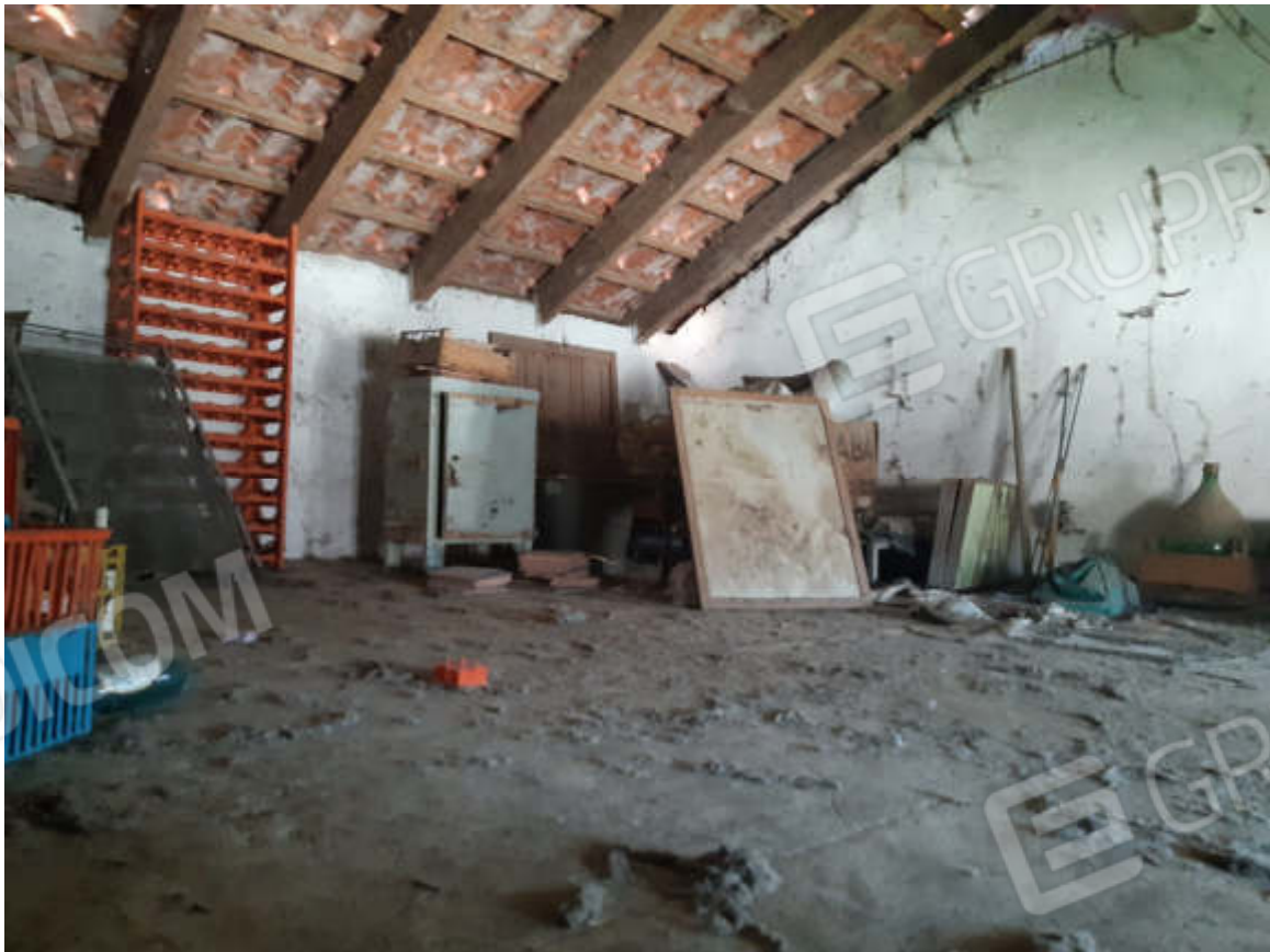
Vista interna locale solaio in piano secondo - sottotetto
