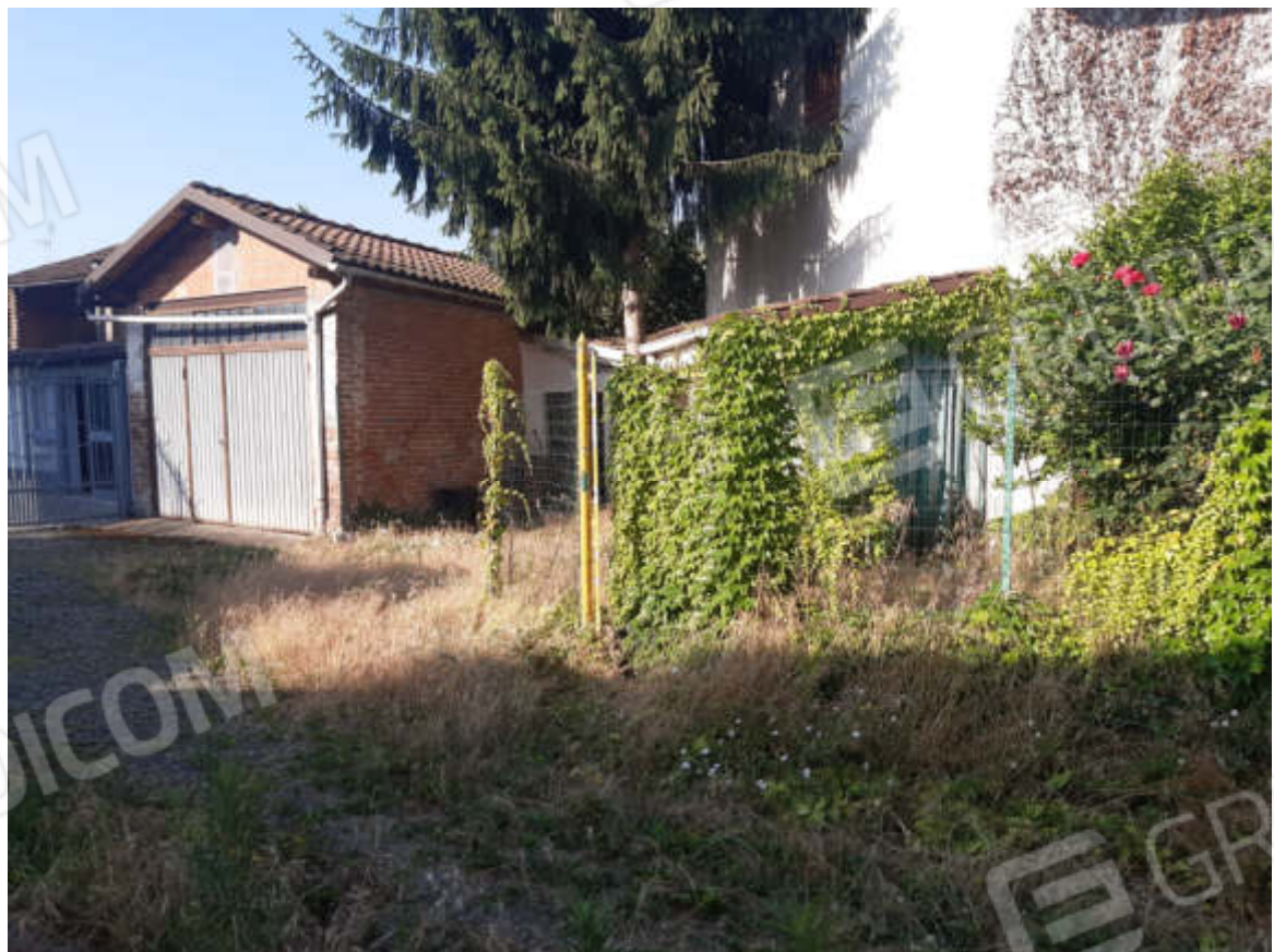
Vista dal cortile pertinenziale posto sul fronte Sud dei piccoli fabbricati accessori destinati a ricovero attrezzi / ripostiglio
