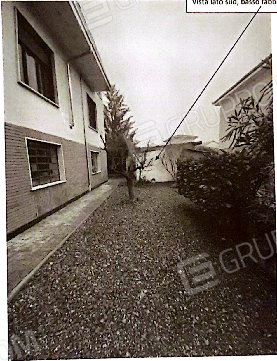
Vista lato sud, basso fabbricato
