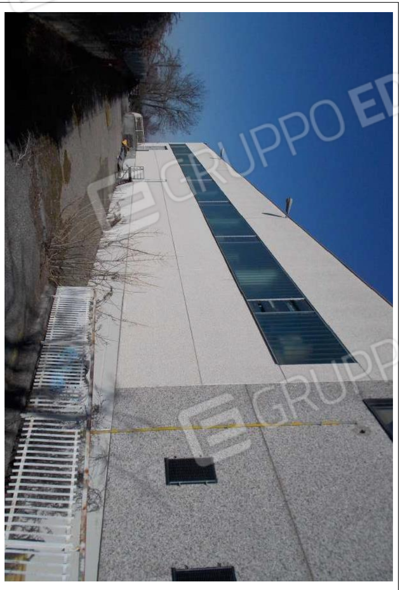
Fotografia n. 10 = LOTTO 2 - CORPO A - Vista esterna
