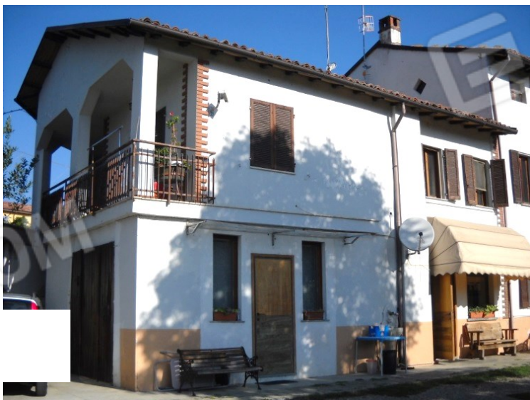
Prospetto da cortile interno
