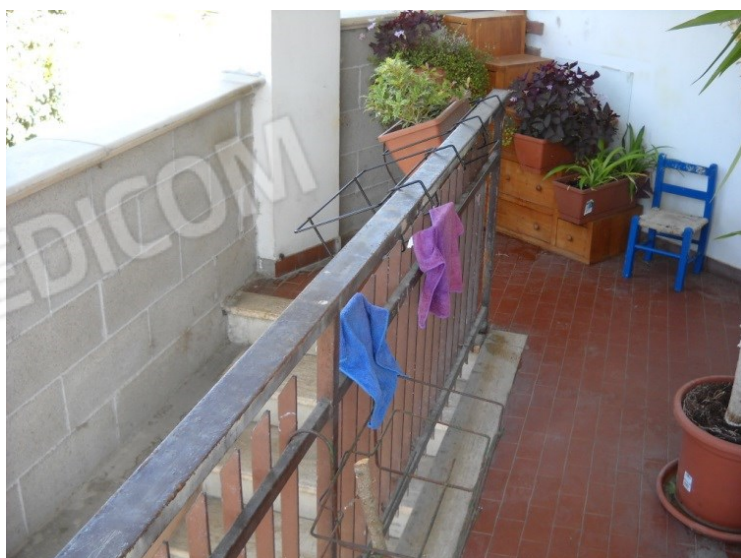
Accesso esterno alloggio piano primo.
