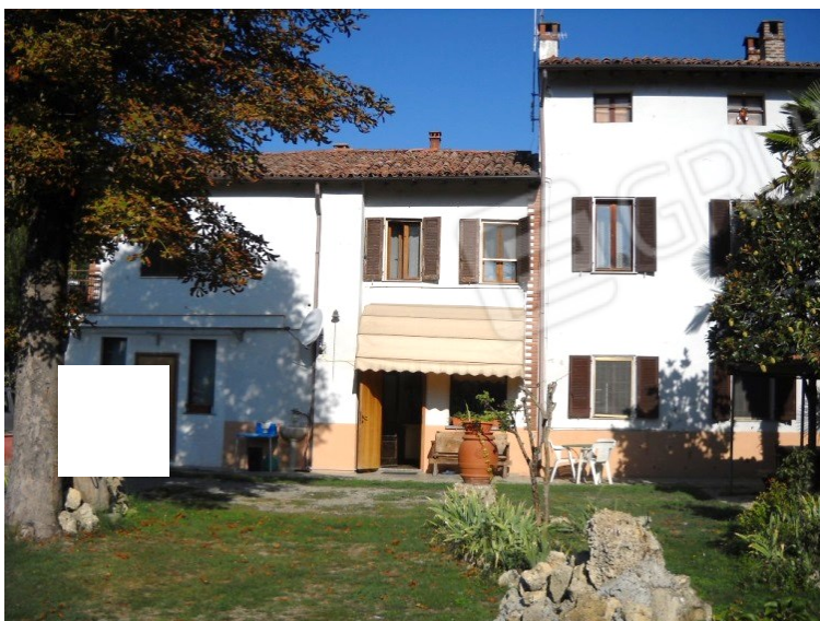
Prospetto da cortile interno
