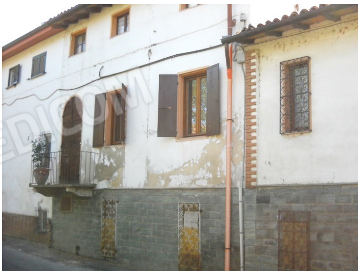
Prospetto da Via dei Mori
