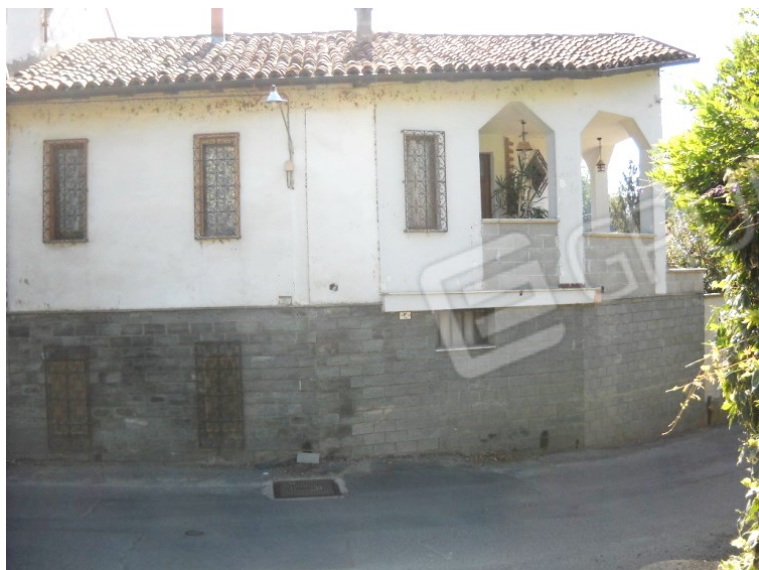
Prospetto da Via dei Mori
