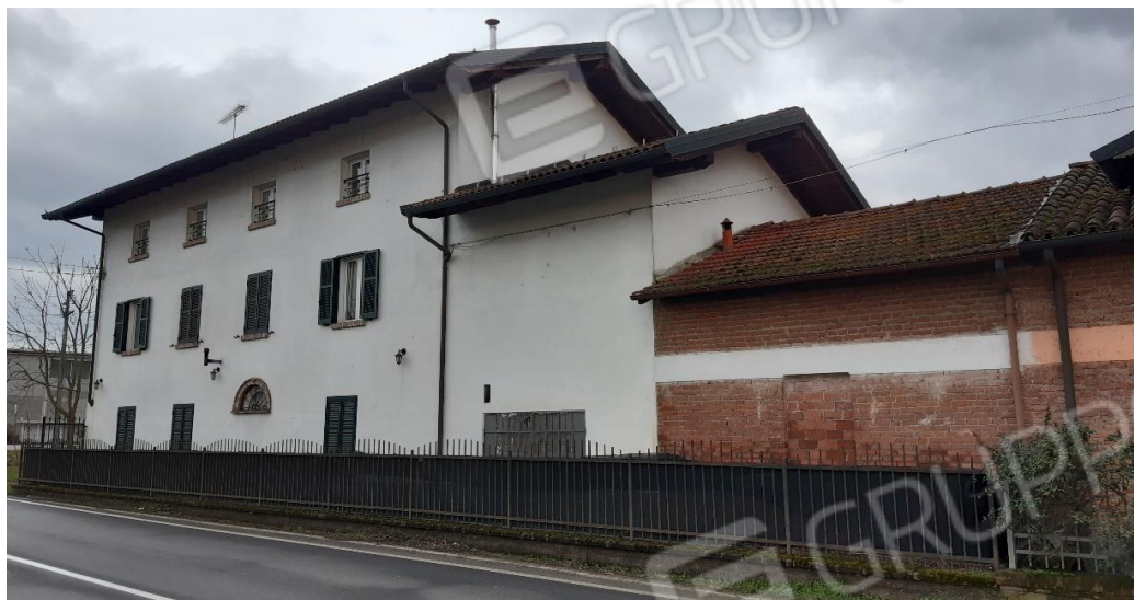
Vista generale dalla provinciale 155
