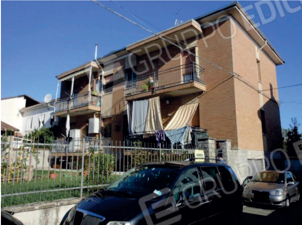
Foto 1 Prospetto frontale su Via Motta fabbricato mapp.851
