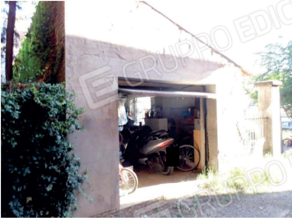
Foto 7 Prospetto laterale da vicolo privato mapp.888 sub.1
