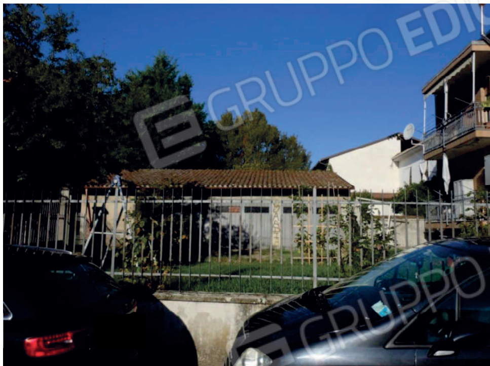
Foto 5 Prospetto frontale da Via Motta fabbricato box mapp.888 sub.1
