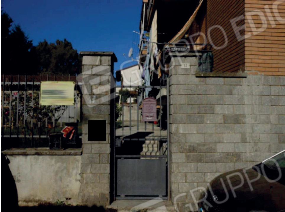
Foto 3 ingresso pedonale su Via Motta
