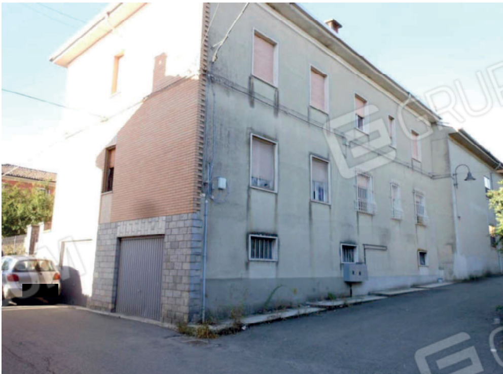
Foto 4 Prospetto retrostante fabbricato mapp.851
