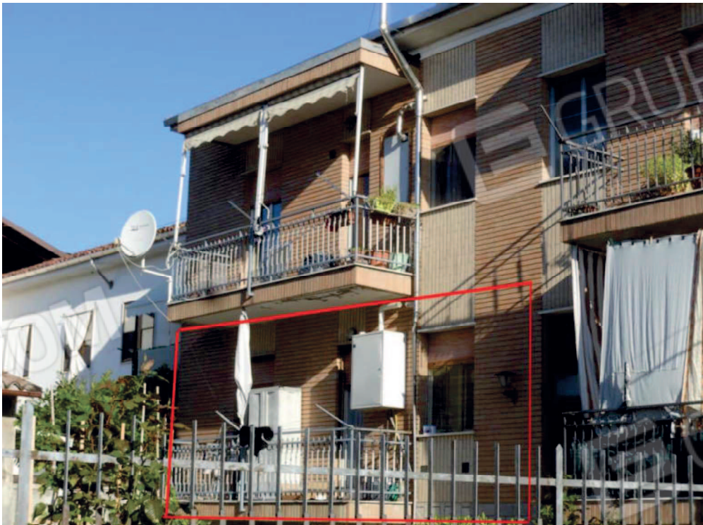
Foto 2 Prospetto alloggio mapp.851 sub.1
