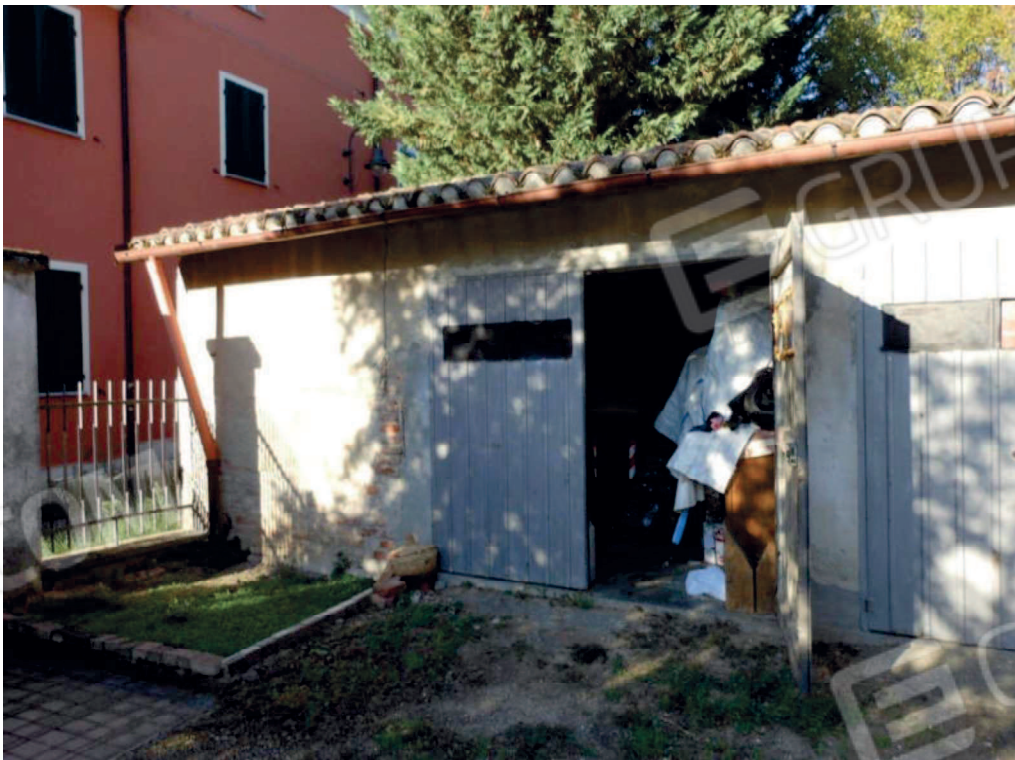
Foto 22 Ingresso box-loc.sgombero mapp.888 sub.1 da sedime interno mapp.851
