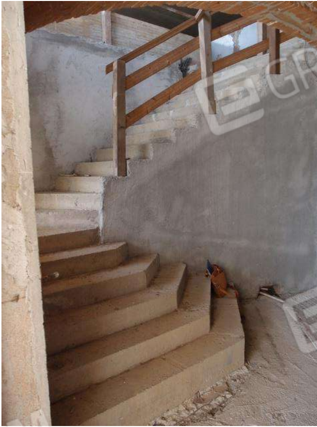
Foto 13 – Vista dell'ingresso con scala al piano terra (sub 2 corpo C)
