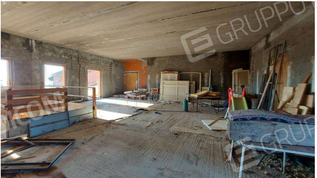
Foto 14 – Vista dell'open space al piano primo (sub 2 corpo C)
