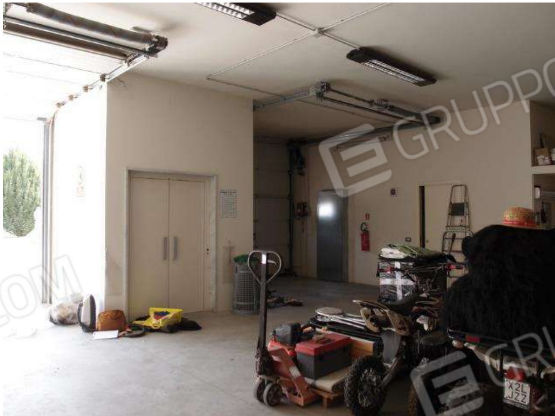
Foto 12 – Vista del garage al piano terra (sub 4 corpo B)
