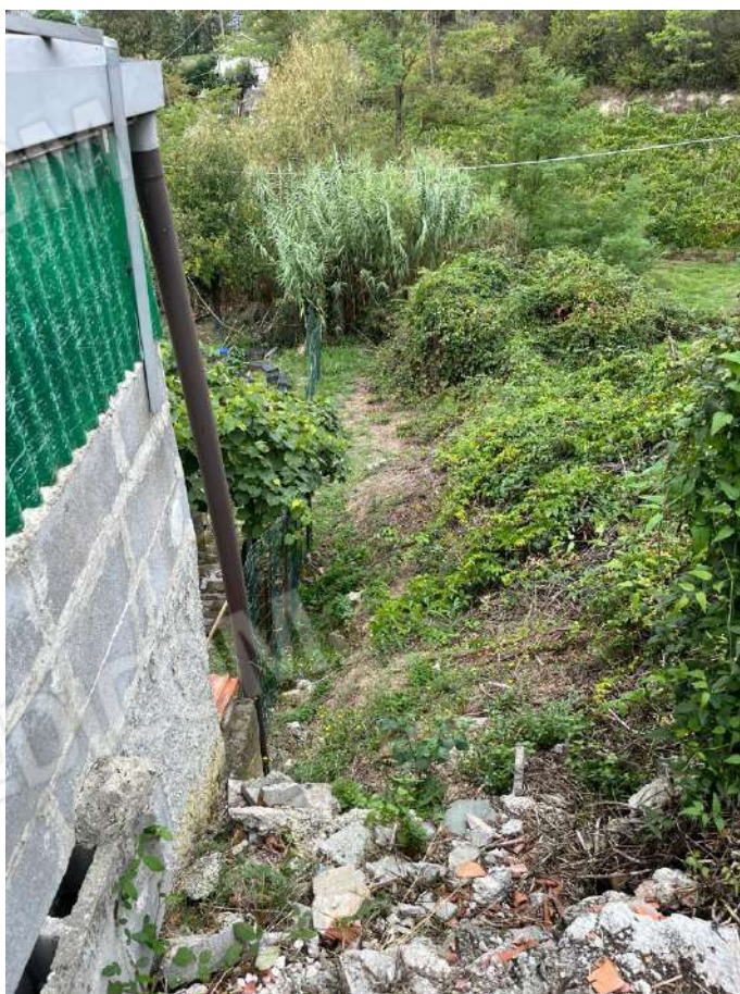
Vista della discesa verso strada del mappale 495
