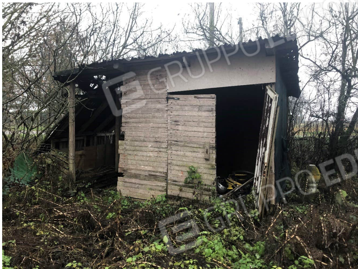
Foto n. 10 – Capanno in legno
