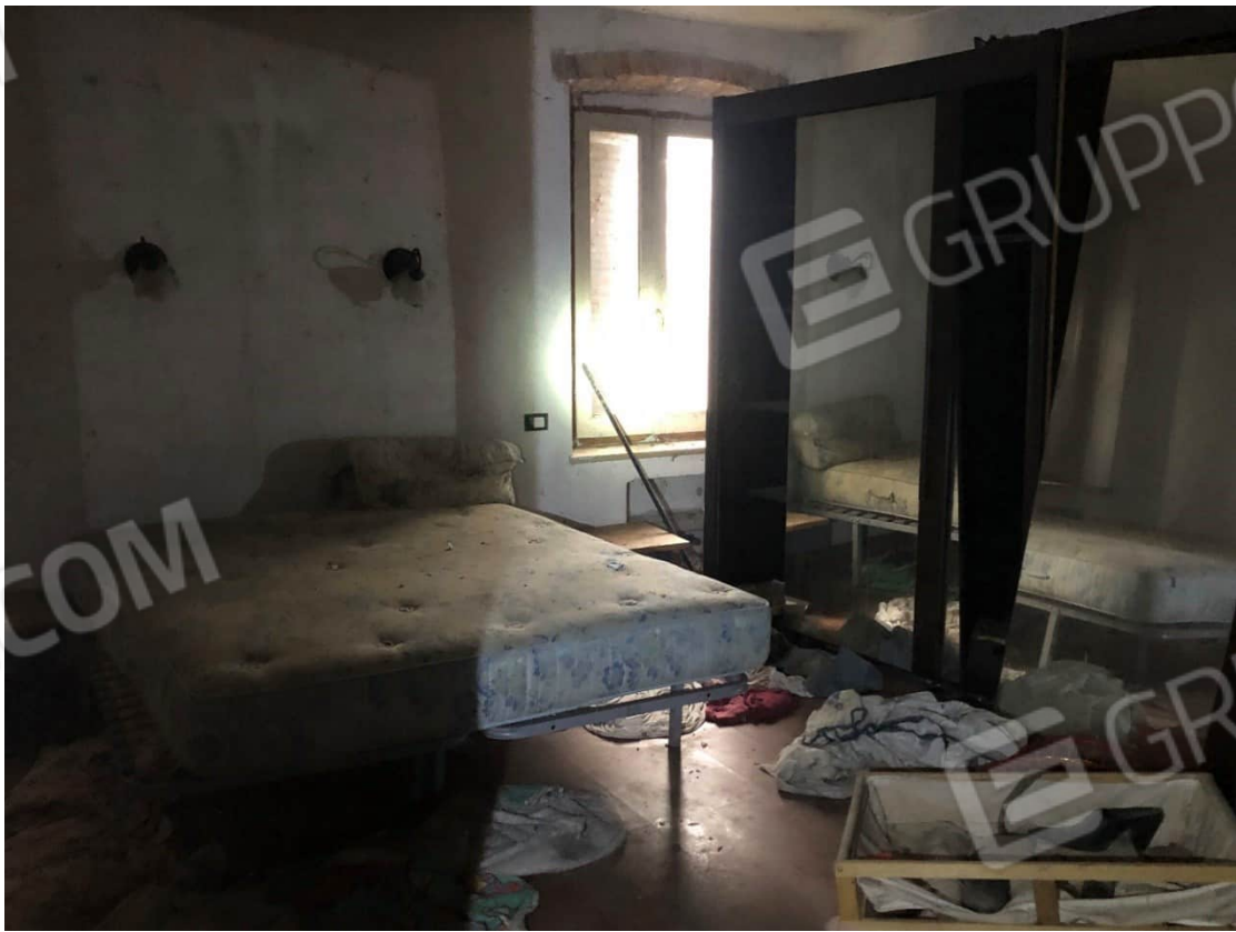
Foto n. 9 – Camera al primo piano
