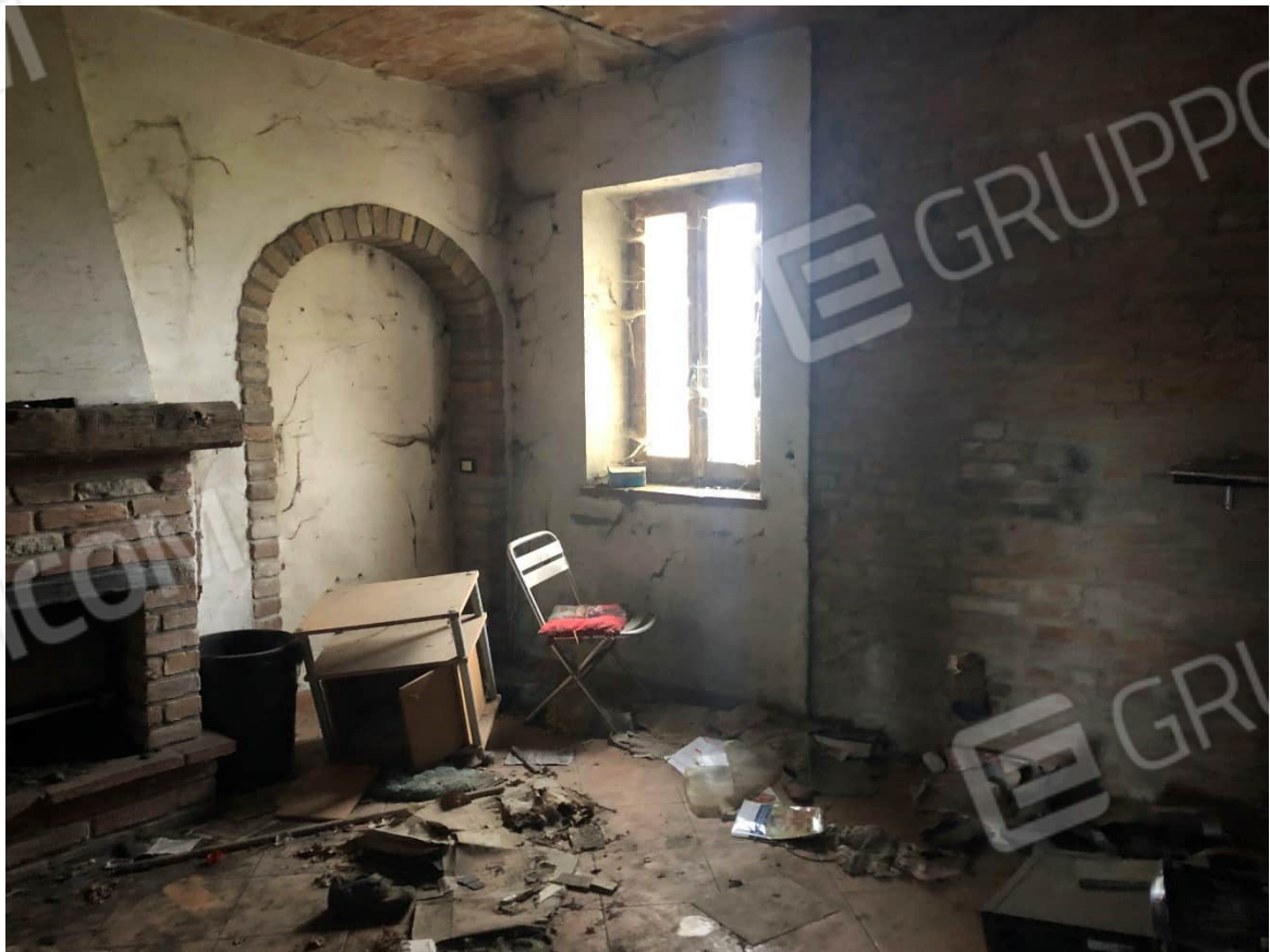
Foto n. 7 – Camera al piano terreno
