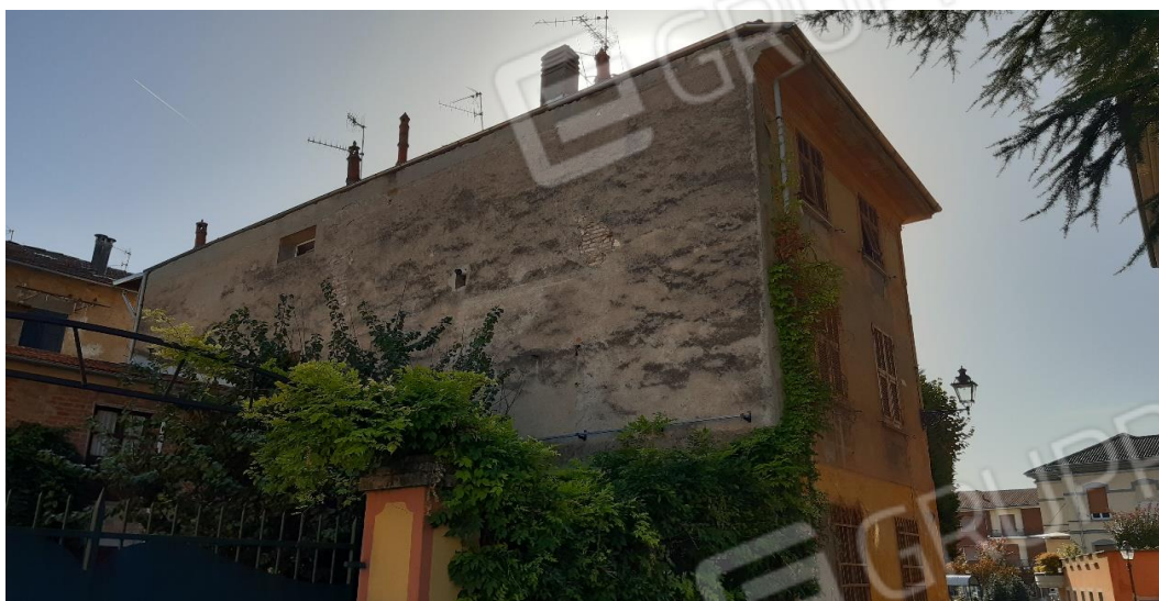
Vista del retro del fabbricato
