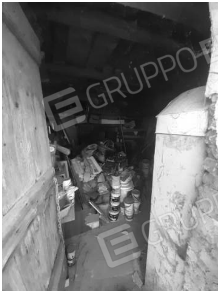
Vista interna locale sgombero / deposito
