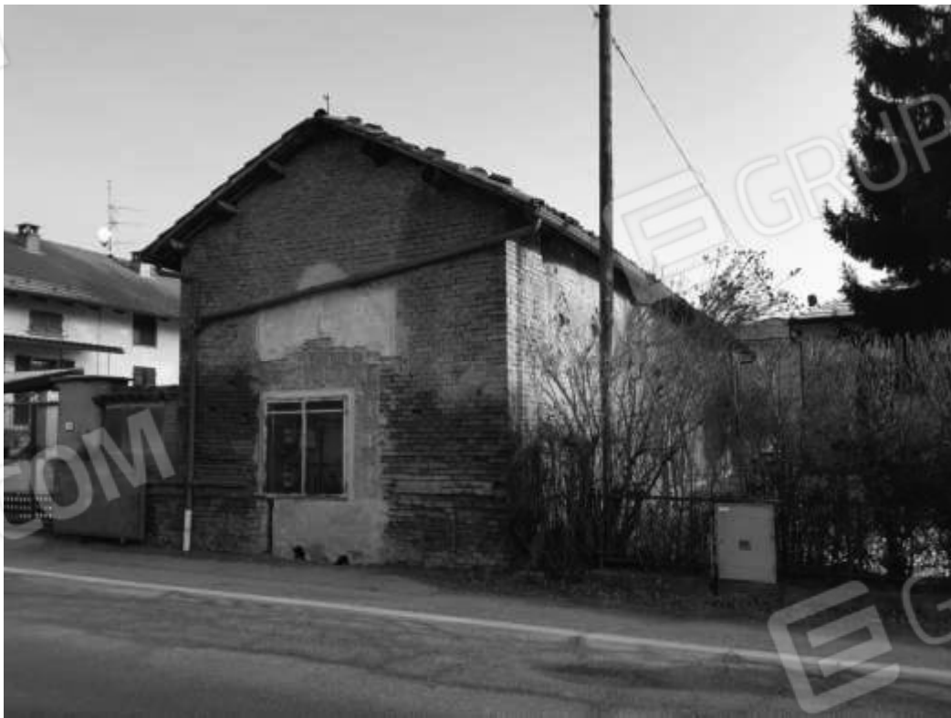
Vista dalla sede stradale pubblica del fabbricato rustico allo stato attuale dei luoghi
