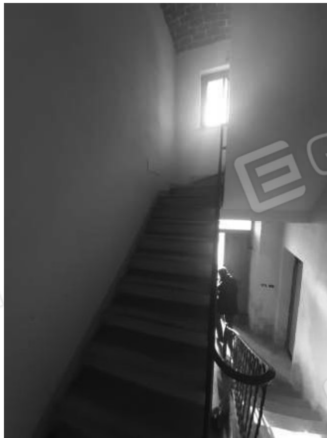
Vista dal piano cortile comune del portoncino di accesso / recesso al / dal vano scala comune del fabbricato urbano
