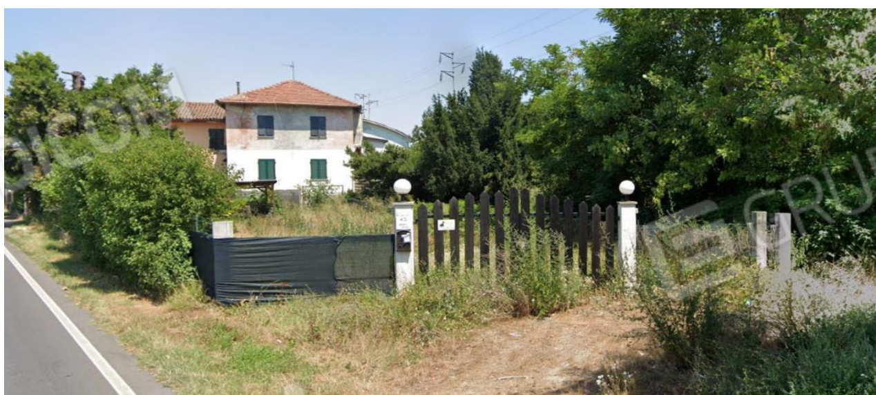
Area esterna vista dalla parte opposta al fabbricato - accesso privo di autorizzazione
