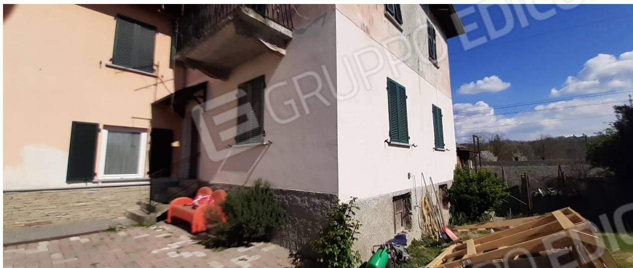
Vista principale del fabbricato
