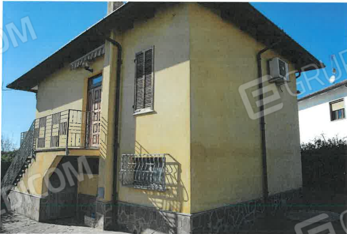
LOTTO 2 FABBRICATO UNIFAMILIARE VALMADONNA – Facciate esterne foto 20-21)
