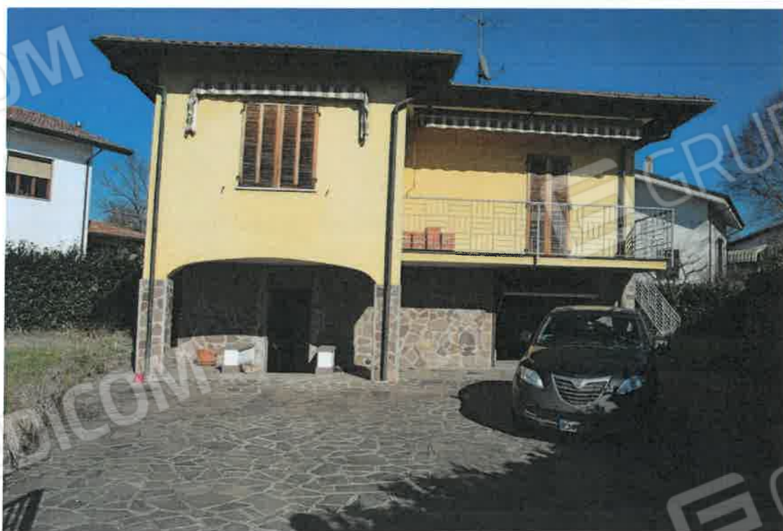
LOTTO 2 FABBRICATO UNIFAMILIARE VALMADONNA – Facciate esterne foto 18-19)
