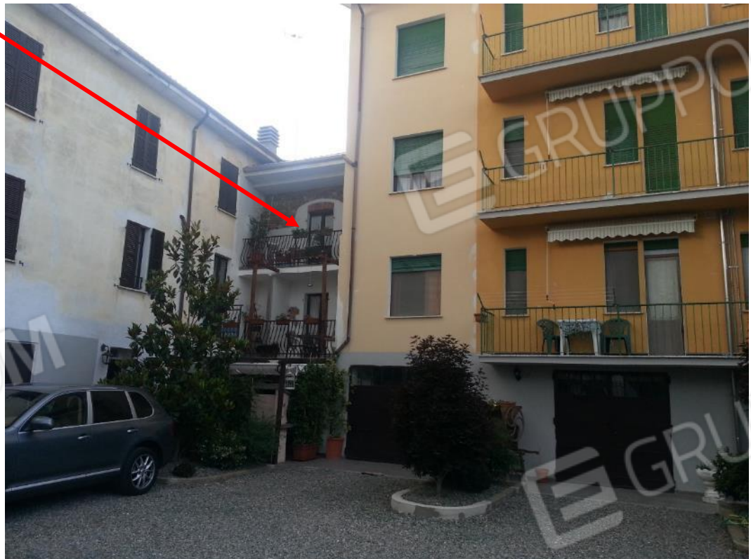
Foto 02 – Prospetto su cortile interno (particella 348)
