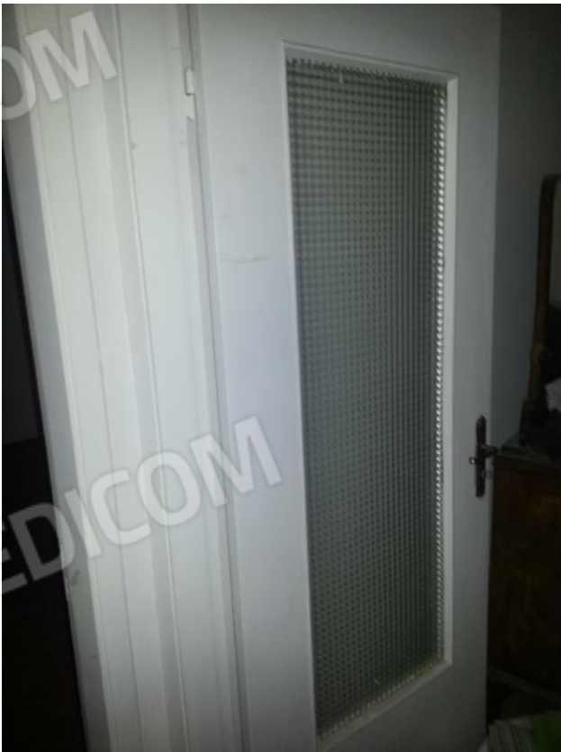
Foto 14 – Dettaglio porta interna subalterno 12
