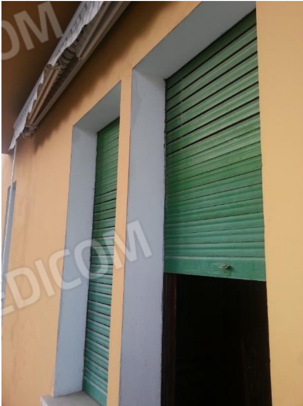
Foto 10 – Dettaglio tapparelle subalterno 12
