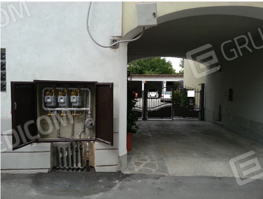
Foto 04 – Via Parsi 2 - Ingresso carraio al cortile interno
