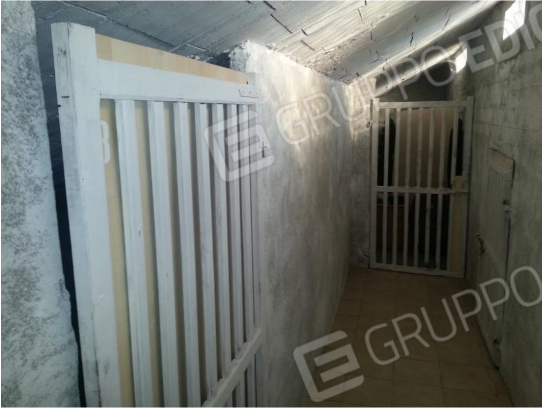
Foto 40 – Sottotetto – soffitte subalterni 13 e 14
