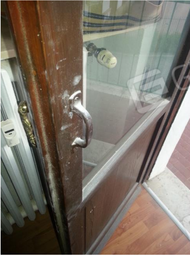
Foto 20 – Dettaglio serramento esterno subalterno 12
