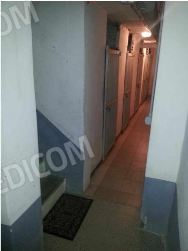
Foto 27 – Vista su corridoio cantine
