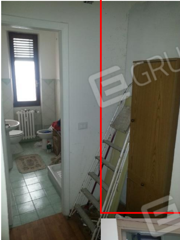
Foto 17 – Ingresso bagno subalterno 12 (piano primo)
