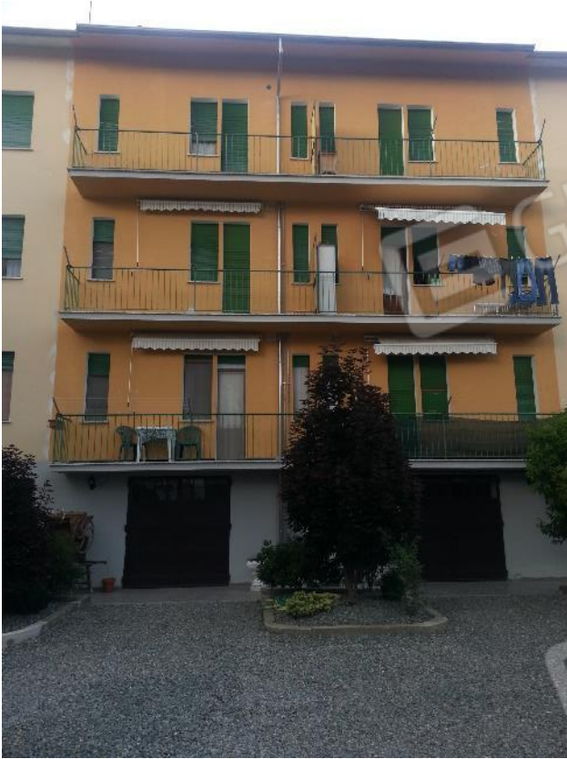
Foto 01 – Prospetto su cortile interno (particella 348)
