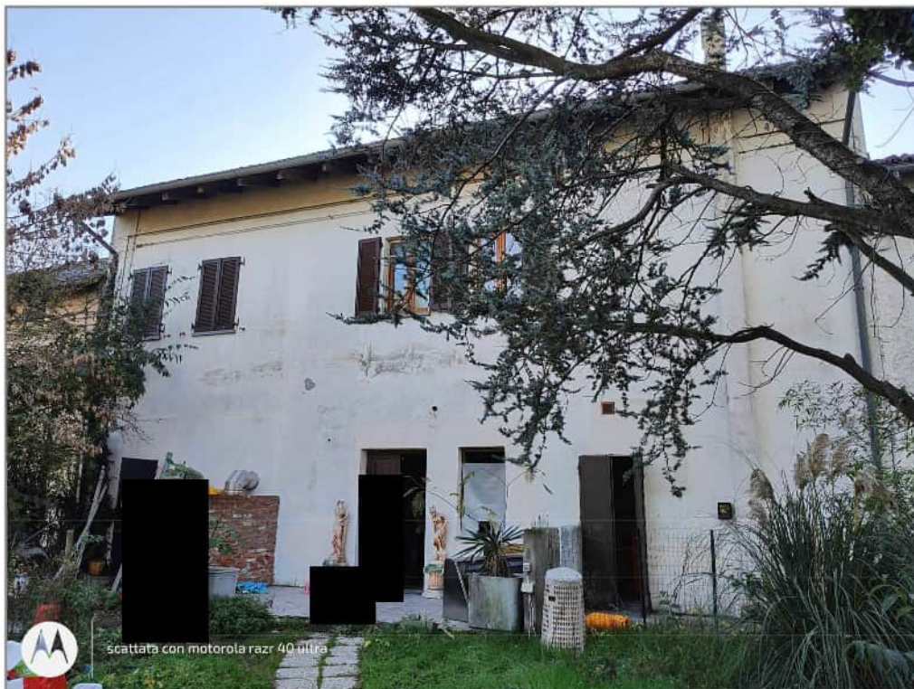
Vista esterna dal cortile di pertinenza del cespite in esecuzione
