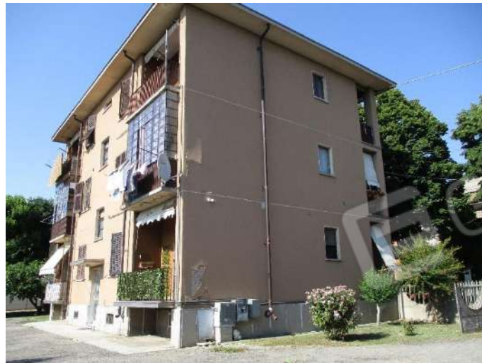
Vista dei prospetti verso la corte comune
