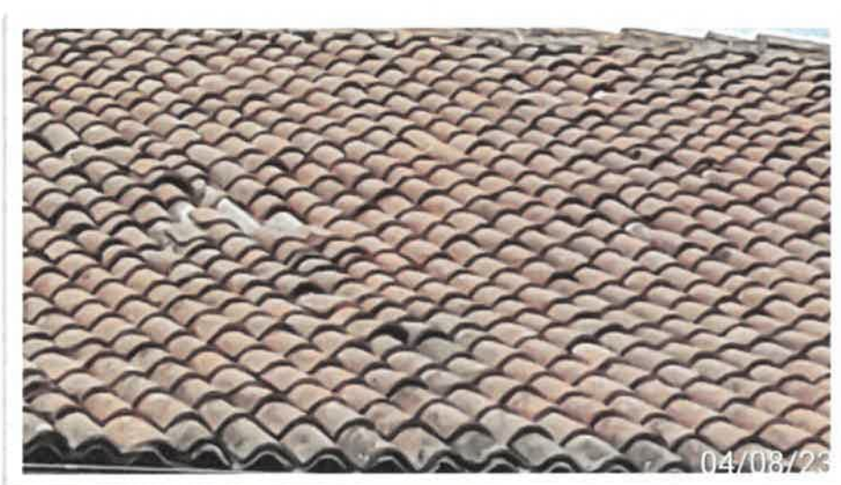
Particolare tetto in coppi da ristrutturare
