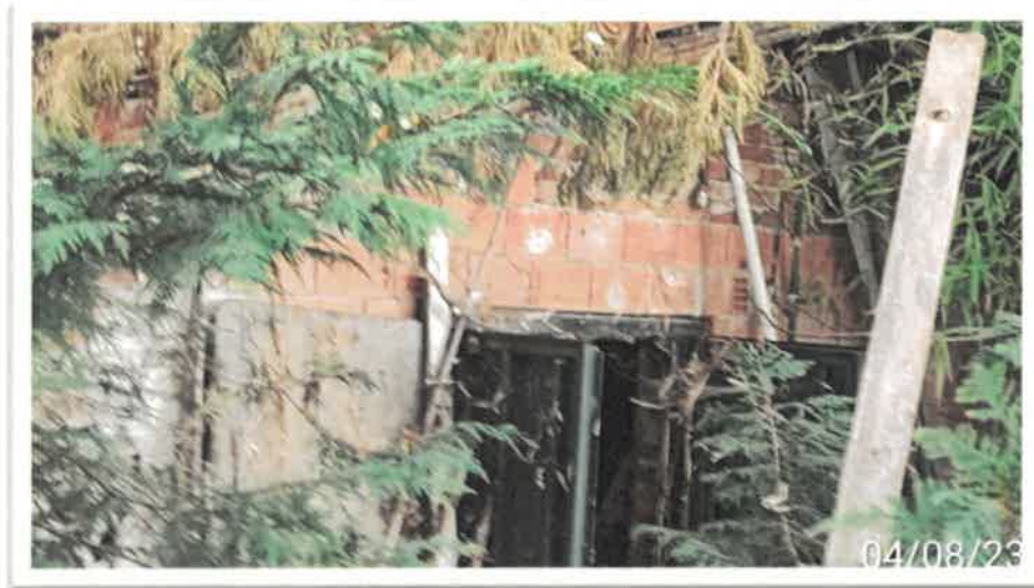
Locali inaccessibili ad uso deposito
