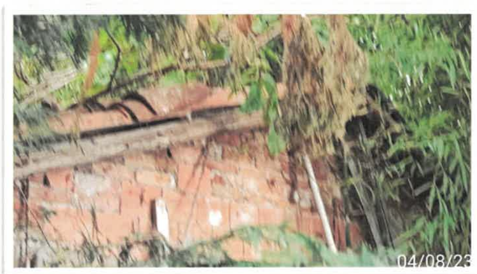
Locali inaccessibili ad uso deposito
