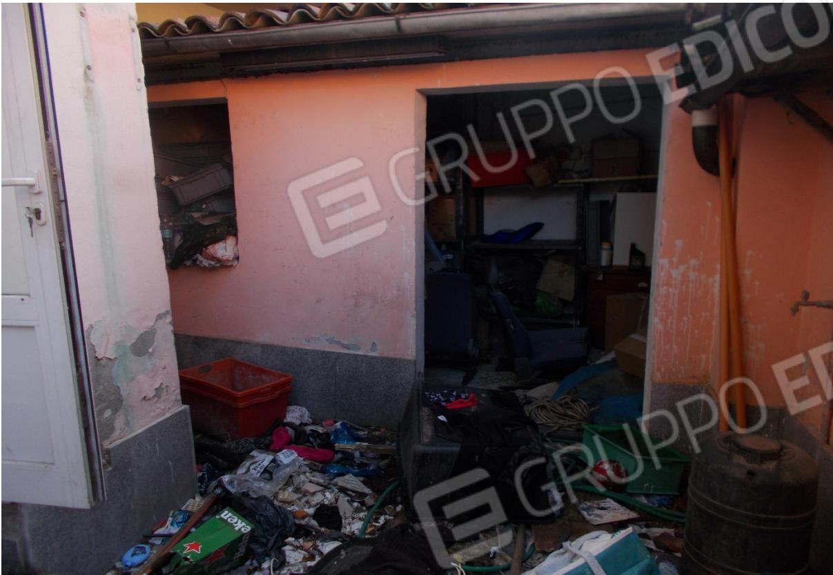
3. piccola area cortilizia di pertinenza posta retrostante il fabbricato
