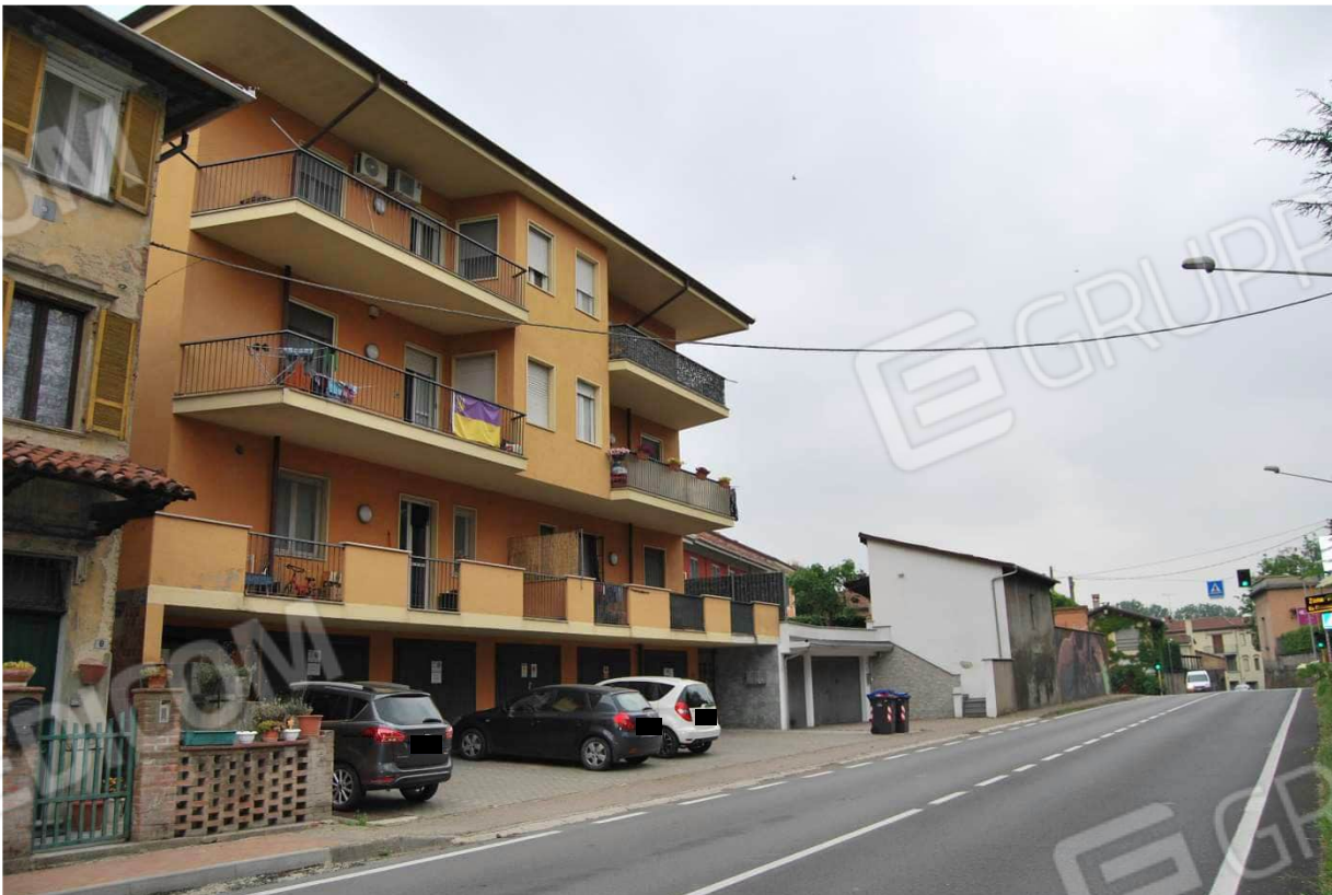
Facciata esterna fabbricato residenziale su strada Padana ovest n 6/A Quattordio. foto 1-2)
