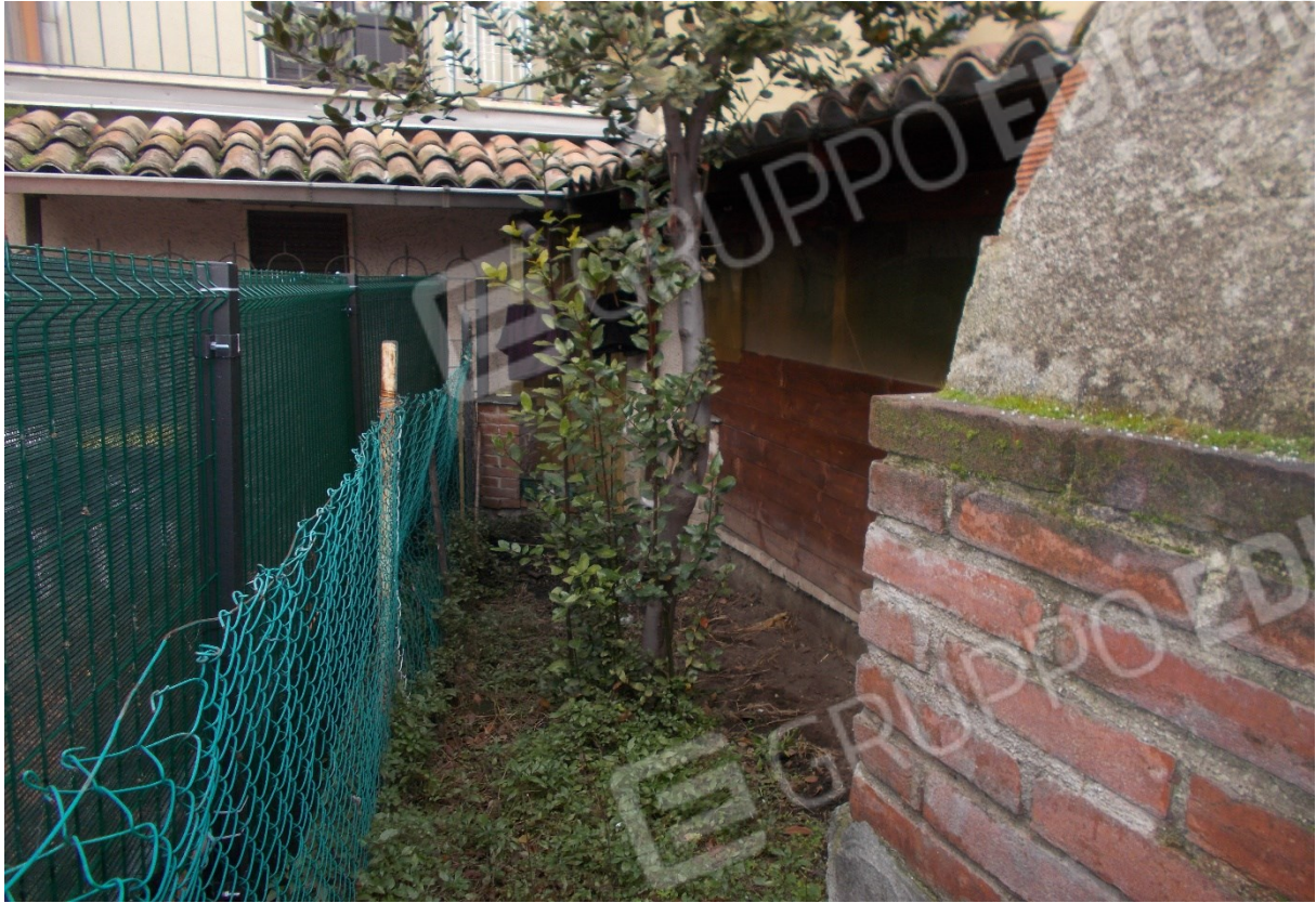
3. Particolare esiguo sedime cortilizio di pertinenza
