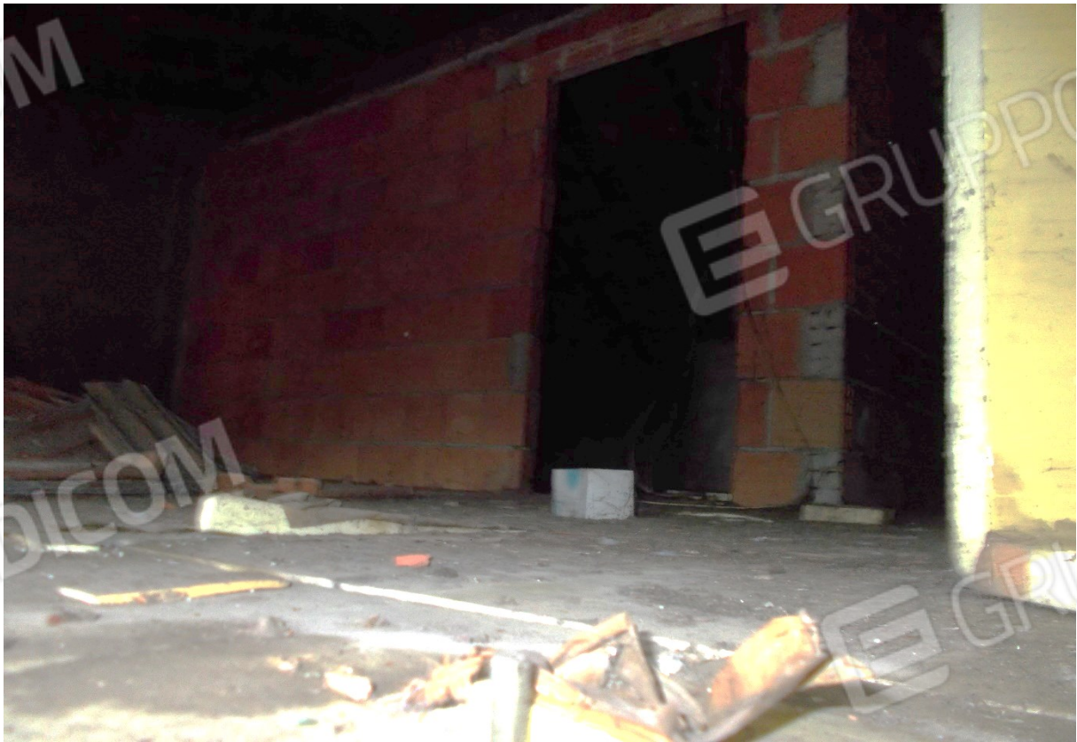
8. Particolare interno - locali sottotetto
