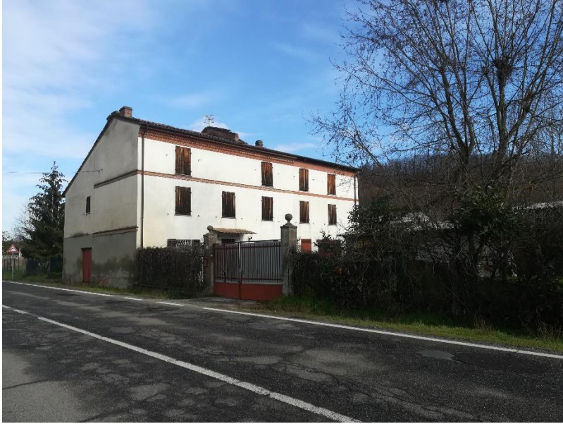
Foto n. 2_ Prospetto sud ed ovest
