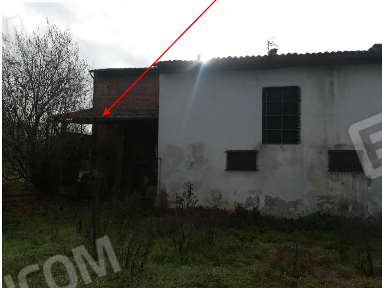
Foto n. 3_ Prospetto nord, tettoia da demolire
