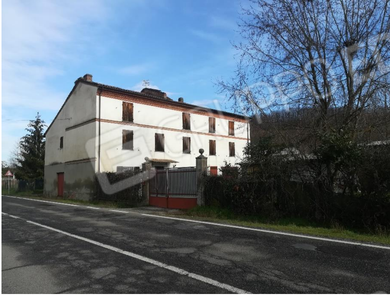
Foto n. 2_ Prospetto sud ed ovest
