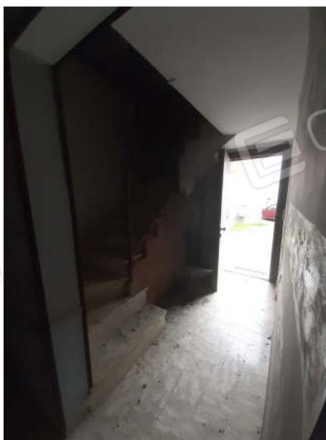
Vista portoncino d'ingresso e vano scala / disimpegno in piano terra
