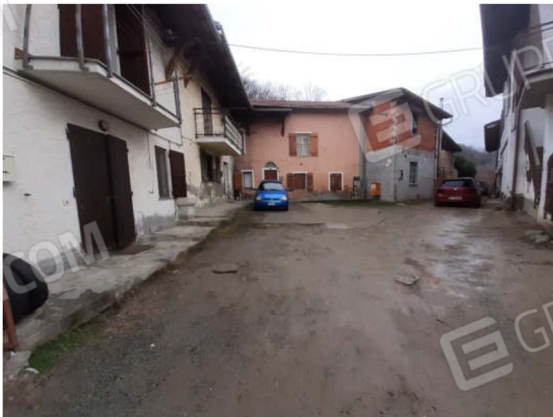
Vista cortile di accesso comune con altre U.I.U. ( Fig. 3 mappale 61 )
