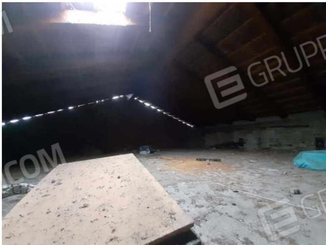
Vista scala di accesso e locale solaio in piano sottotetto
