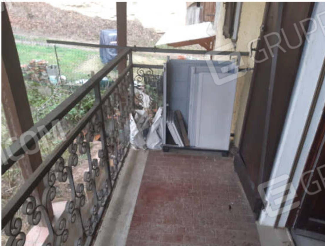
Vista tipologia rifiniture balconi in piano primo
