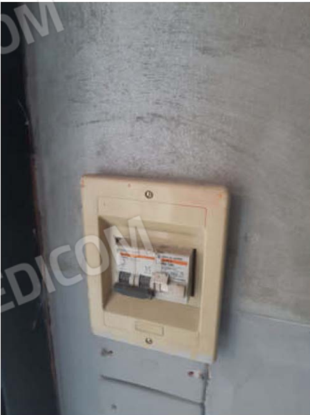
Vista interruttore generale impianto elettrico
