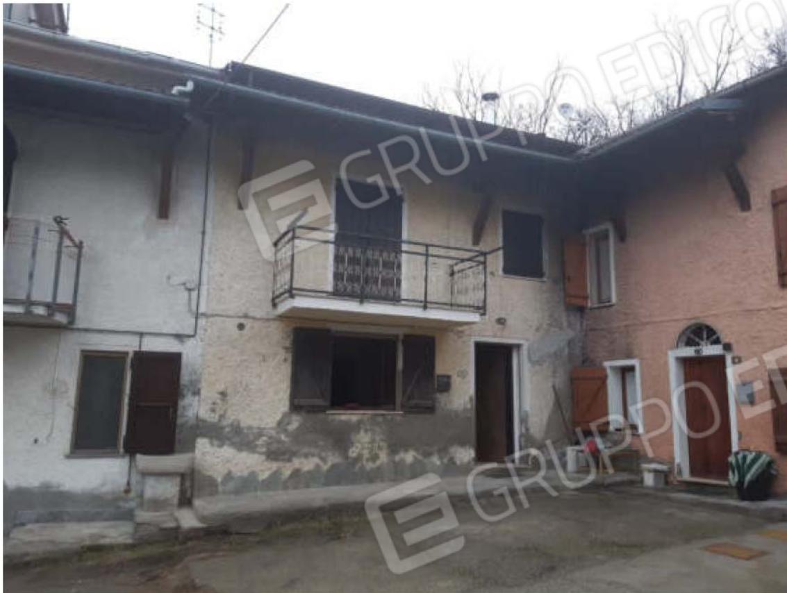
Vista fronte Est del fabbricato oggetto di stima
