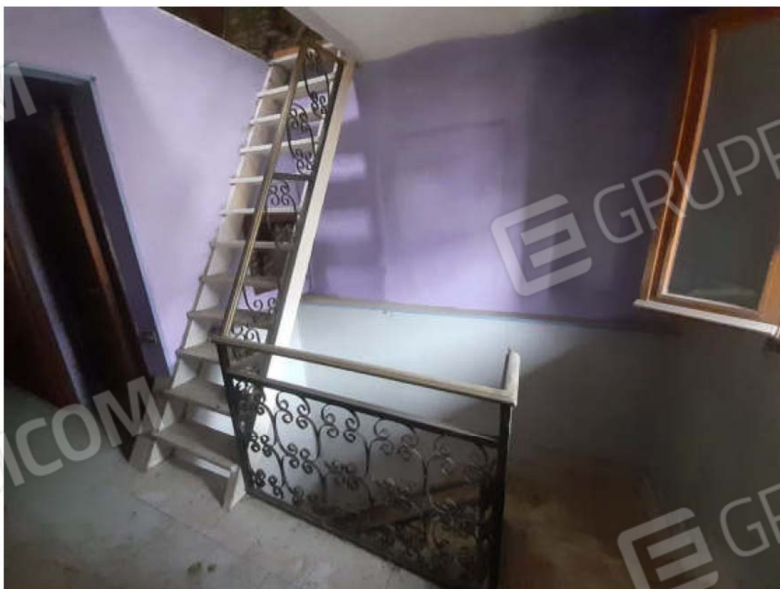
Vista vano scala e sbarco quota piano primo
