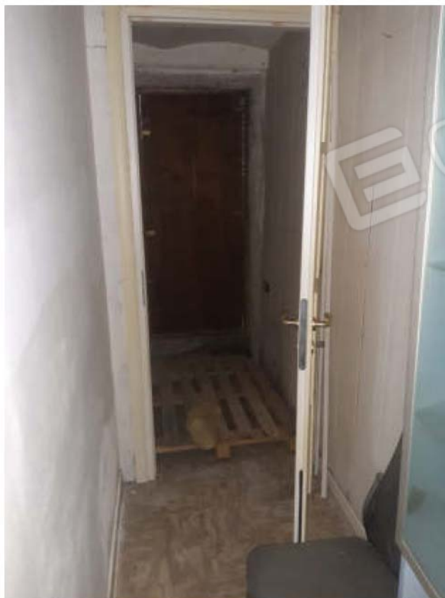
Vista interna locale ripostiglio in piano terra
