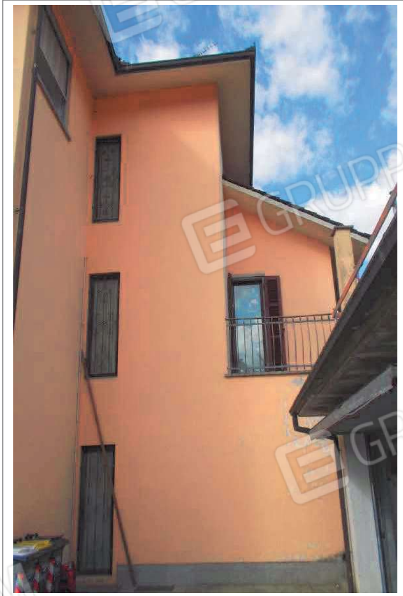
Fotografia n. 18 = LOTTO 2 Vista di parte del del prospetto SUD
