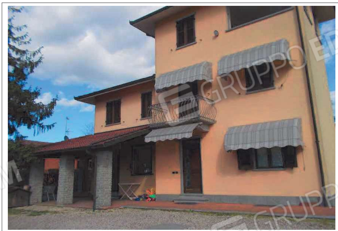
Fotografia n. 17 = LOTTO 2 Vista del prospetto OVEST
