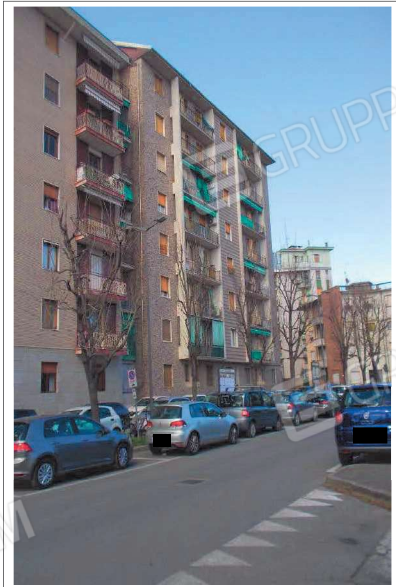
Fotografia n. 1 = LOTTO 1 CORPO A Vista del Condominio del Sole da Via San Giovanni Bosco
