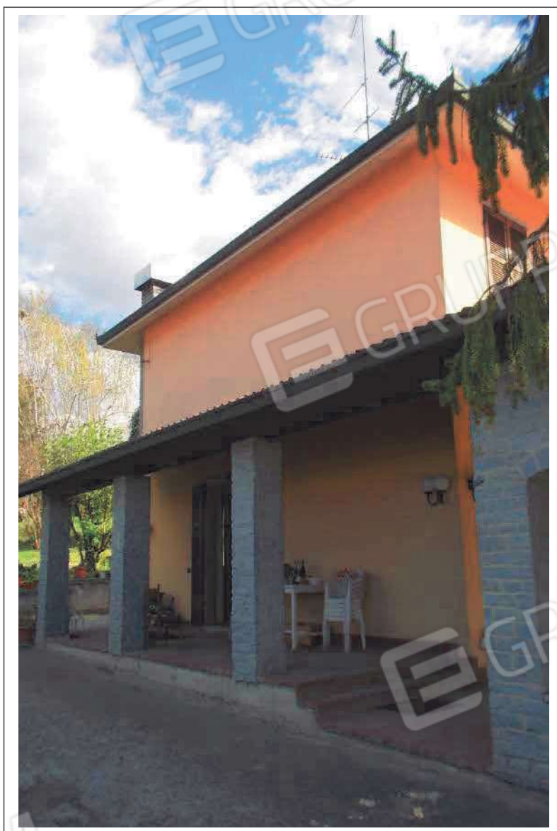
Fotografia n. 16 = LOTTO 2 Vista del prospetto NORD
