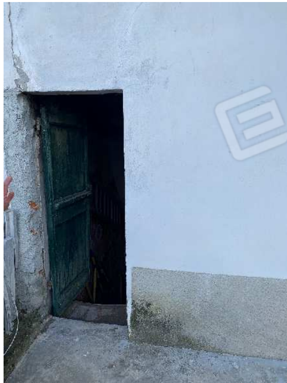
accesso alla cantina
