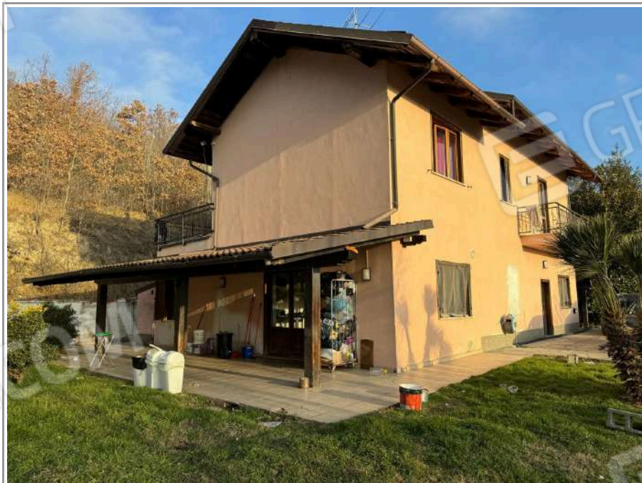
Foto n.2 prospetti sud e ovest
