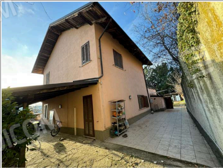
Foto n.4 prospetto nord ovest
