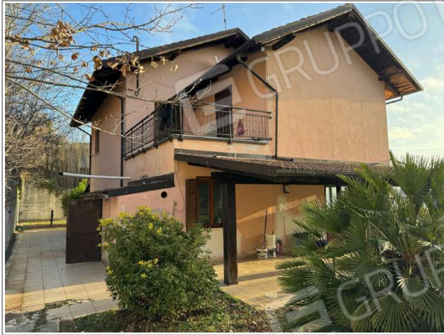
Foto n.3 prospetto sud ovest
