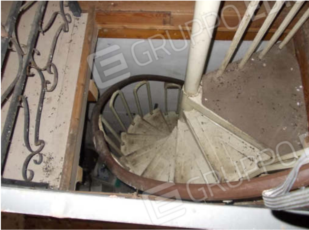
Foto 31 Locale di sgombero (fabbricato interno cortile) scala accesso piano primo
