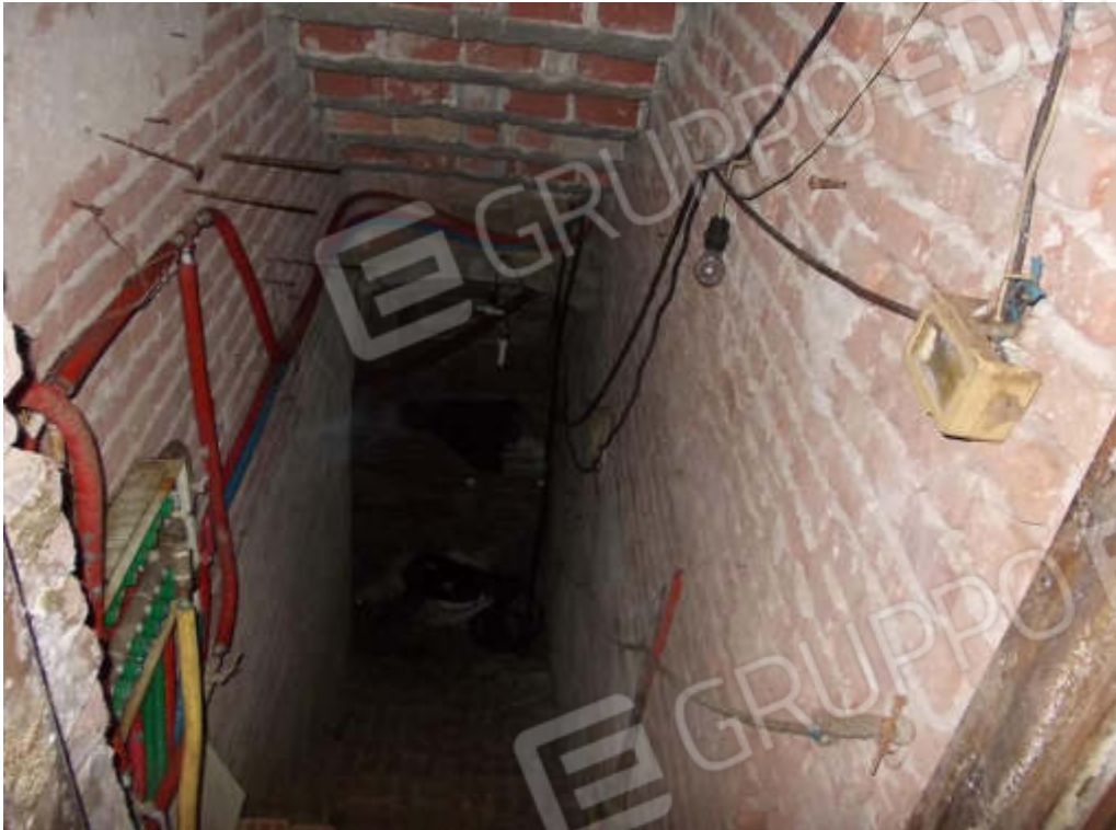
Foto 25 Cantina piano interrato
