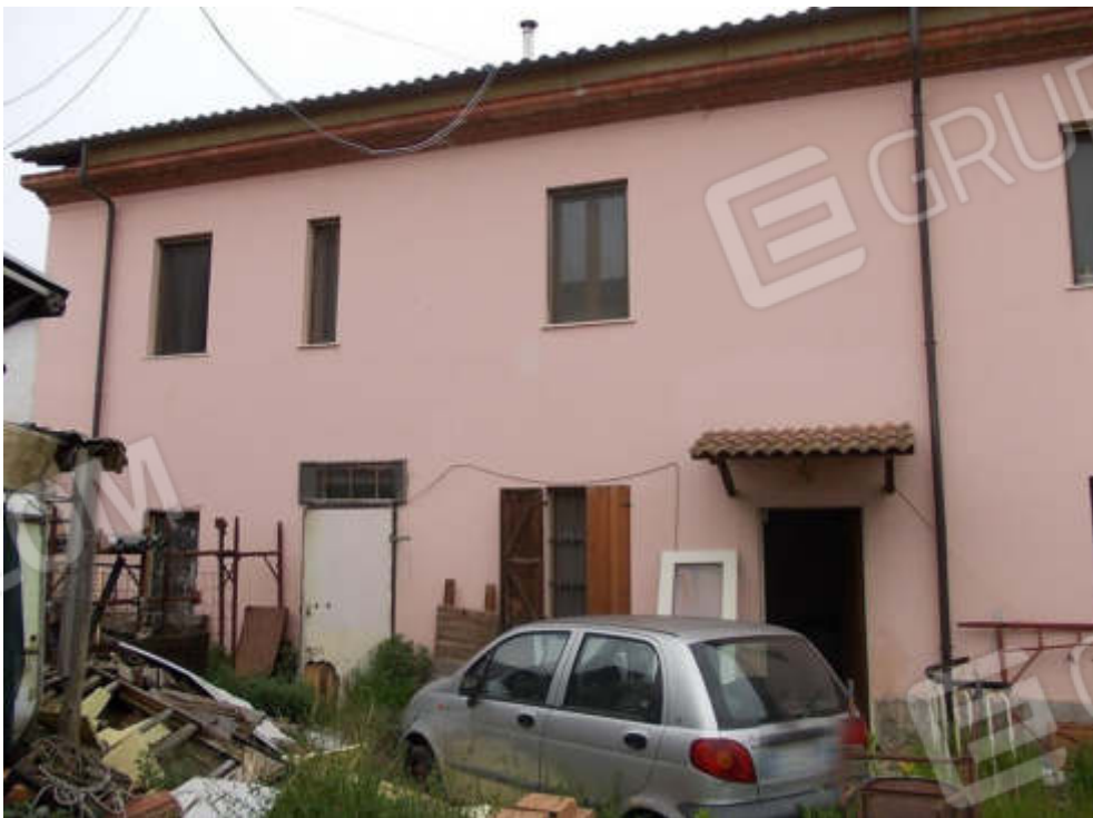
Foto 8 Prospetto sud fabbricato da interno cortile
