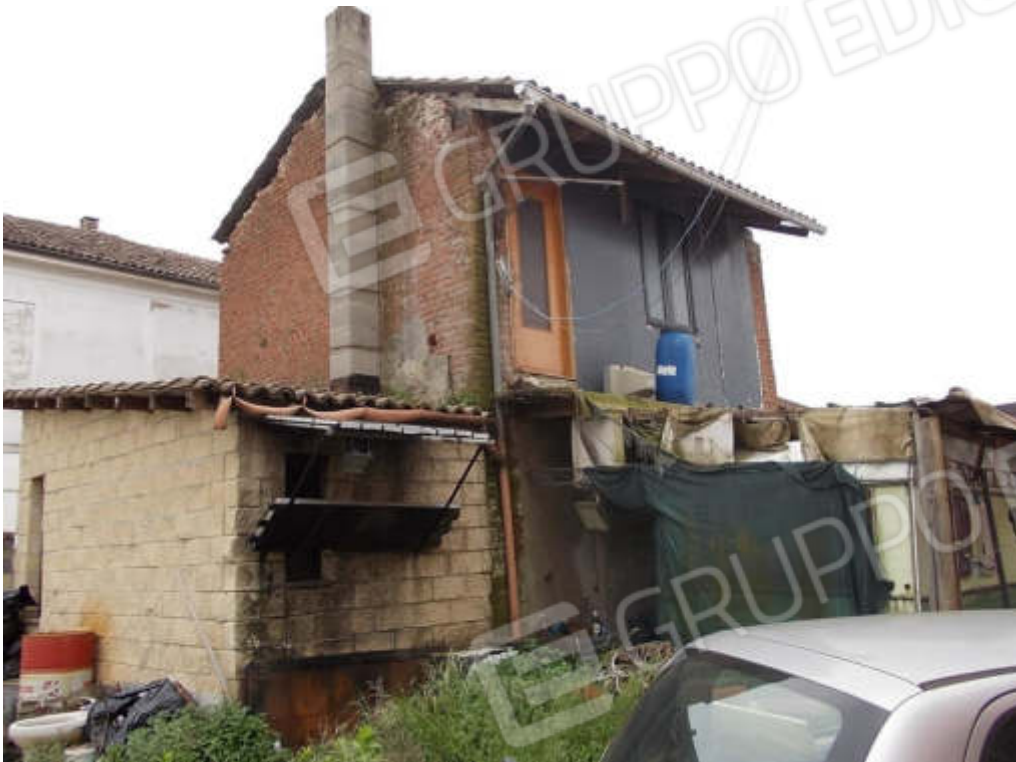
Foto 7 Prospetto nord/est locale di sgombero da interno cortile
