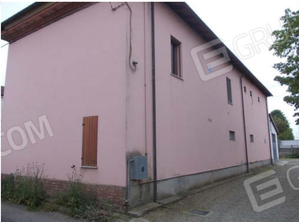
Foto 4 Prospetto nord/est fabbricato da strada
