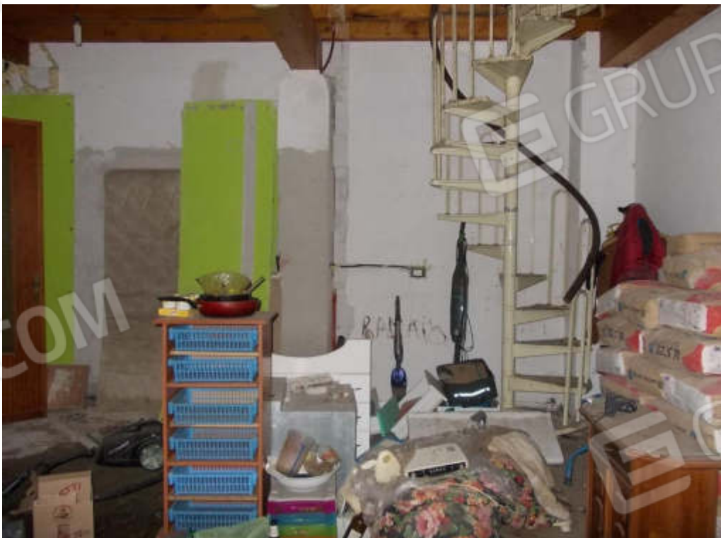
Foto 28 Locale di sgombero (fabbricato interno cortile) piano terra
