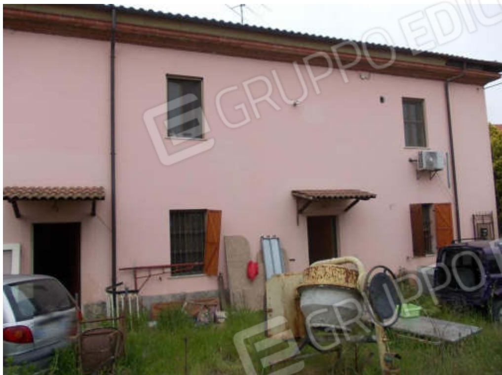
Foto 9 Prospetto sud fabbricato da interno cortile
