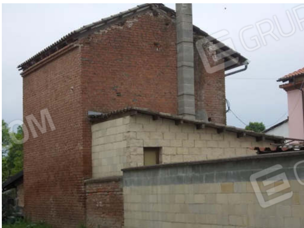
Foto 6 Prospetto sud/est locale di sgombero posto all'interno corrale
