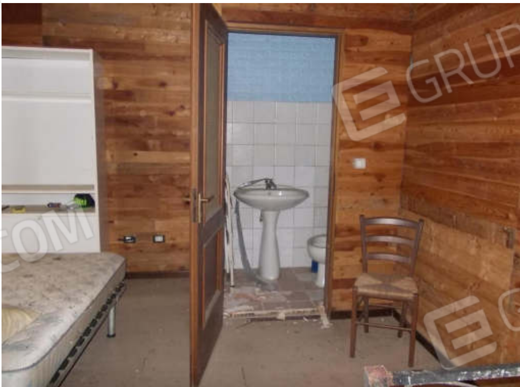
Foto 32 Locale di sgombero (fabbricato interno cortile) piano primo
