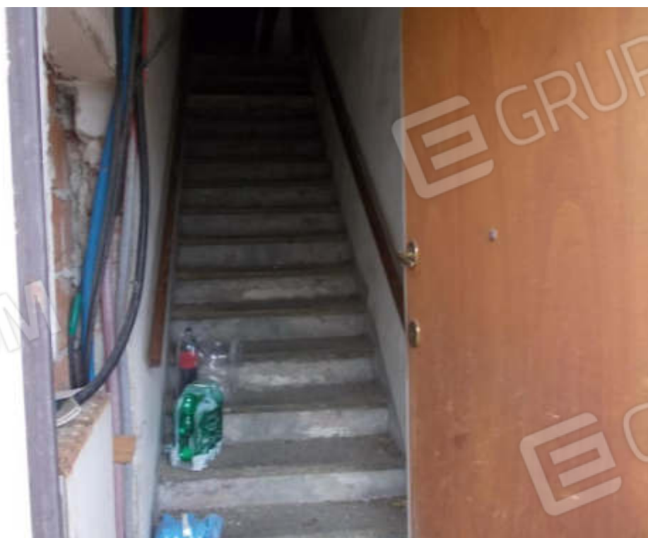
Foto 10 Ingresso/scala accesso al piano primo
