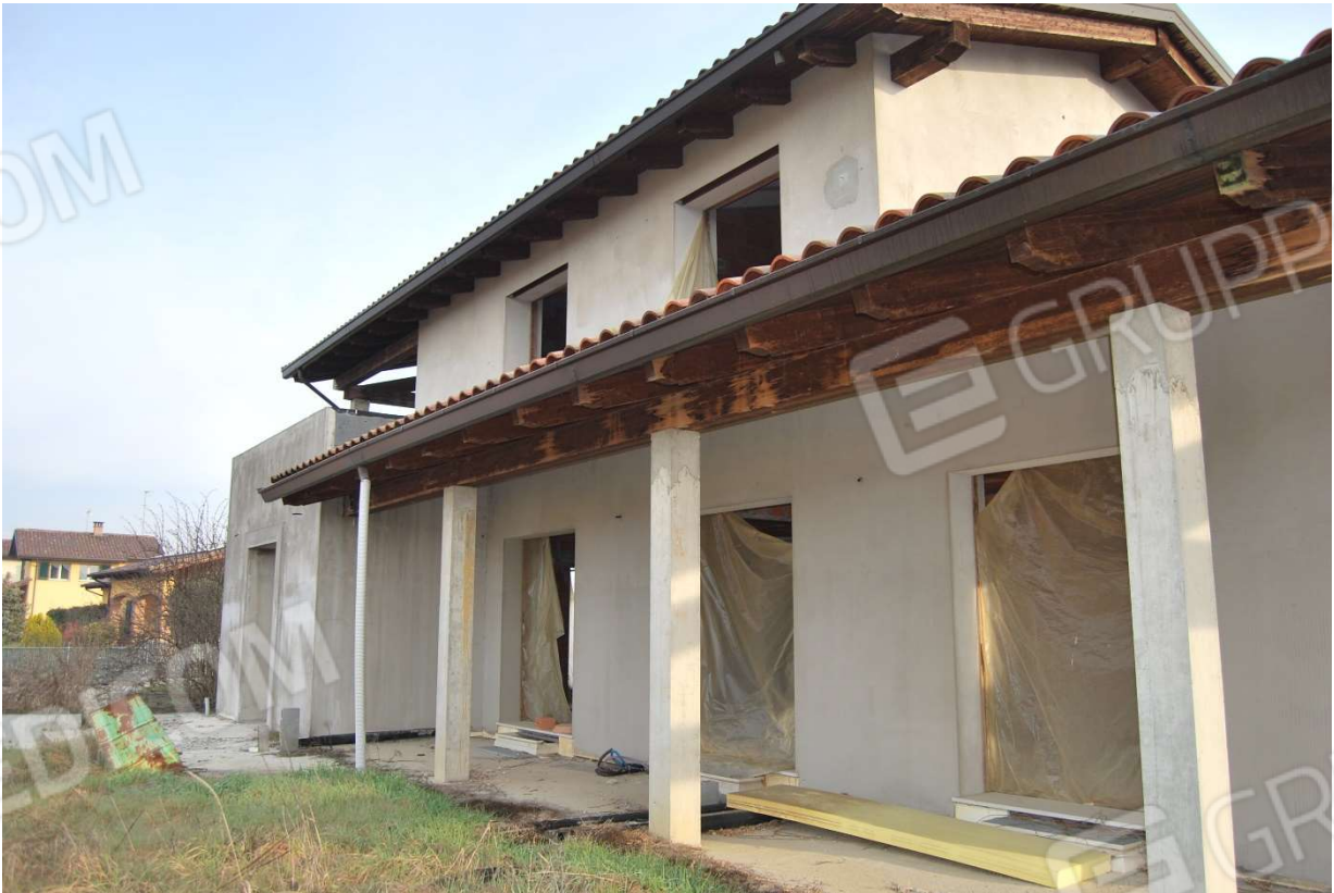
Facciate esterne fabbricato residenziale in costruzione, via Kennedy, Quargento (AL) foto 1-2)
