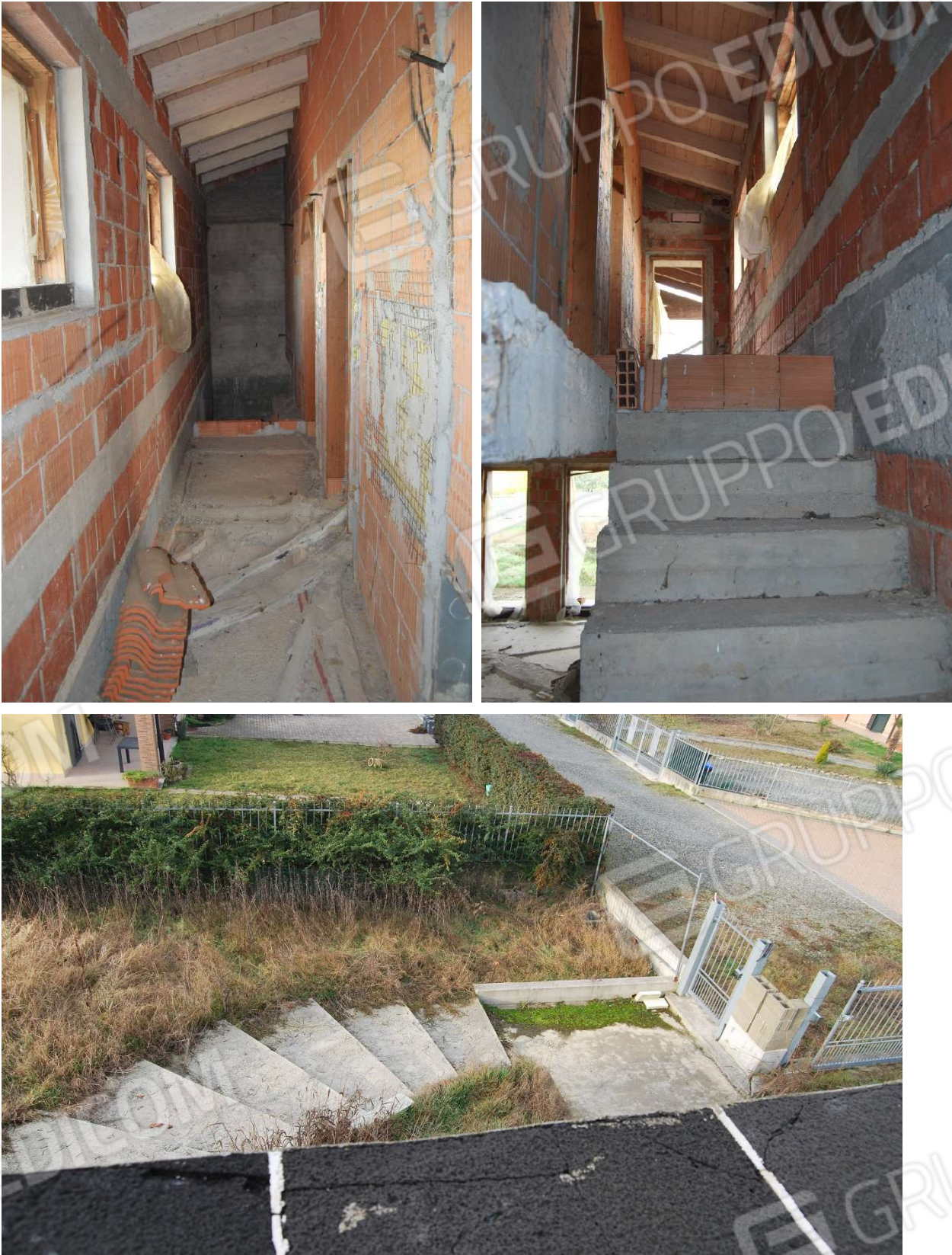
Disimpegno e scala accesso al P 1°, scaletta esterna , via Kennedy, Quargento (AL) foto 19-20)
