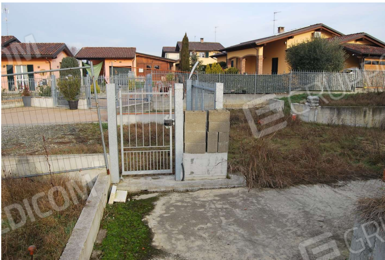
Area pertinenziale, ingresso carraio e pedonale, via Kennedy, Quargento (AL) foto 23-24)
