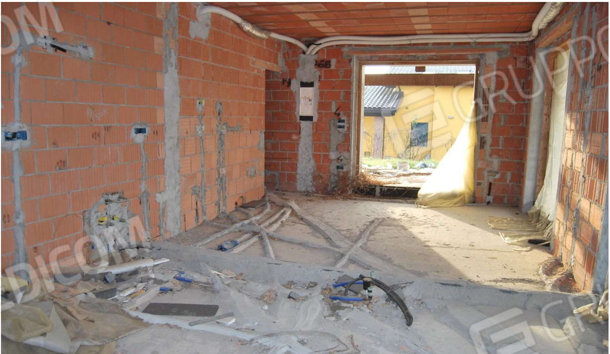
Predisposizione impianti tecnologici, via Kennedy, Quargento (AL) foto 13-14)
