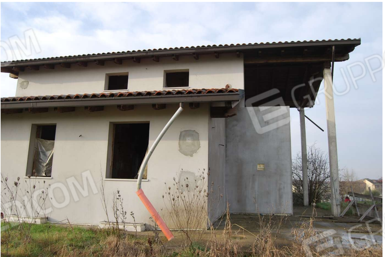
Facciate esterne fabbricato residenziale in costruzione, via Kennedy, Quargento (AL) foto 3-4)
