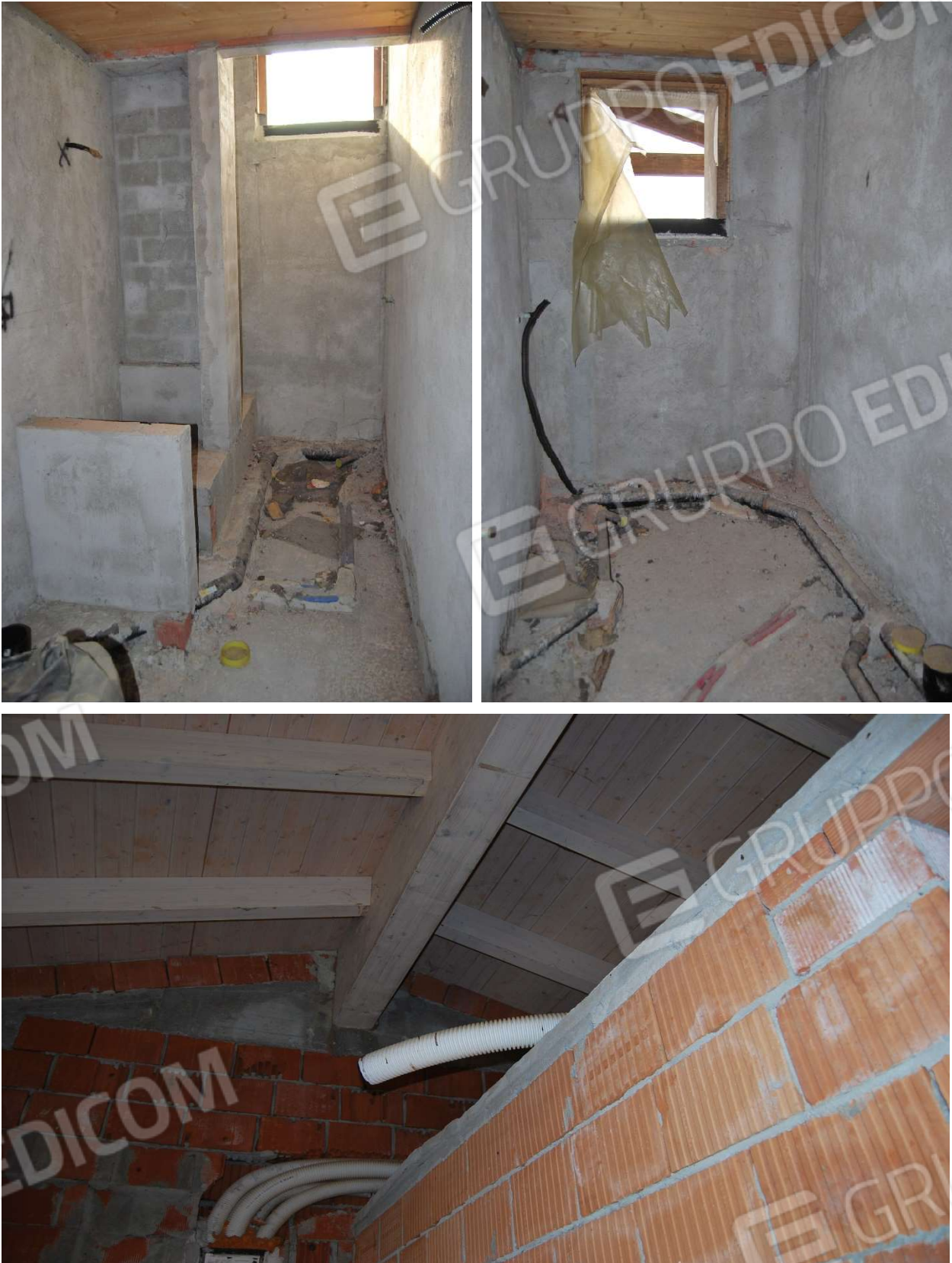
Bagni e tetto a vista in legno lamellare con isolamento termico al P 1° , via Kennedy, Quargento (AL) foto 17-18)
