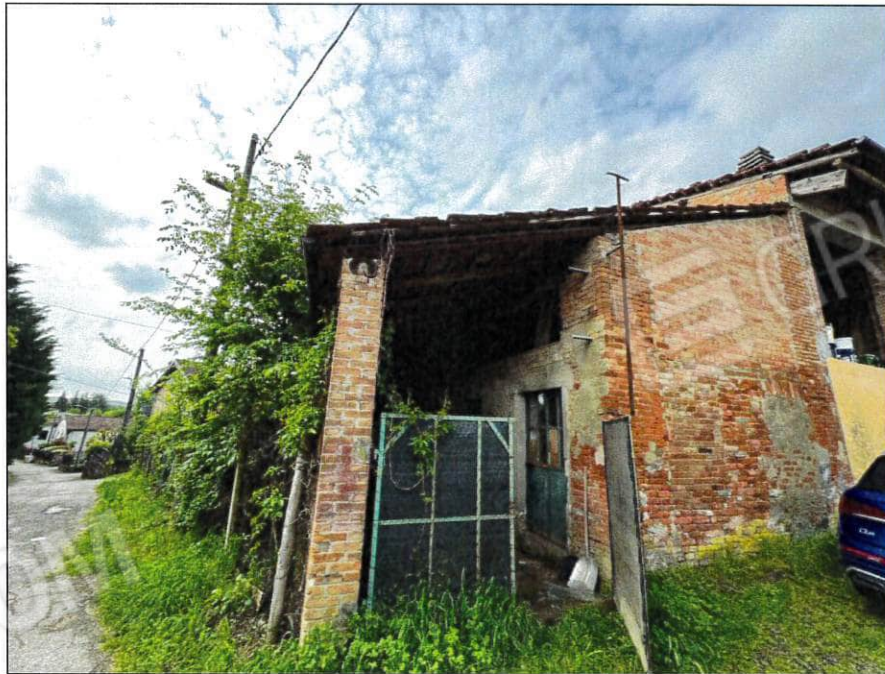
Immagine 35: Prospetto fabbricato secondario
