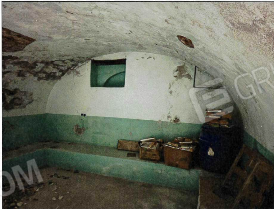
Immagine 30: Cantina piano interrato
