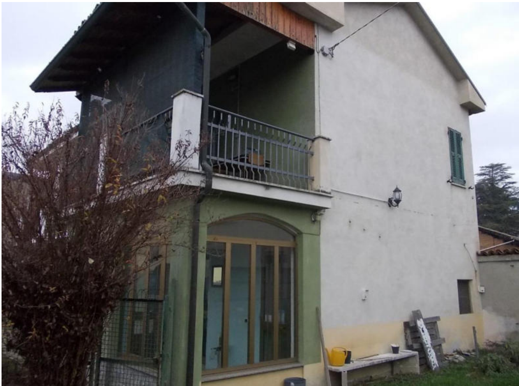
Foto 4 Prospetto sud fabbricato mapp.371 sub.1,sub.2
