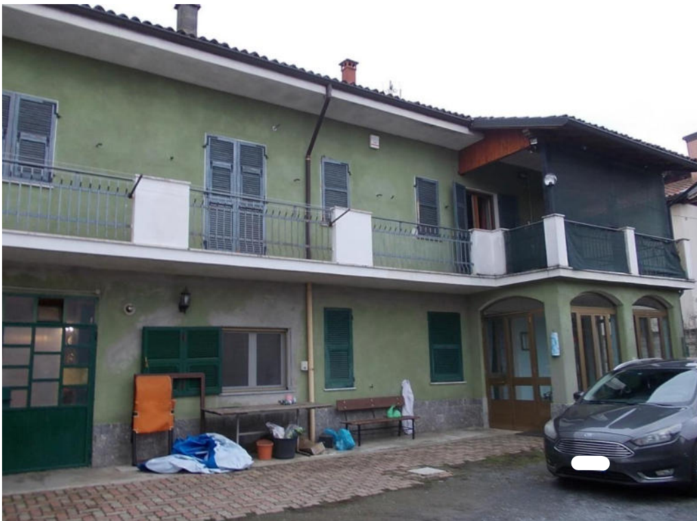
Foto 2 Prospetto ovest fabbricato mapp.371 sub.1,sub.2
