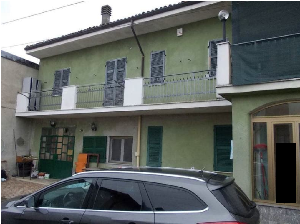
Foto 3 Prospetto ovest fabbricato mapp.371 sub.1,sub.2
