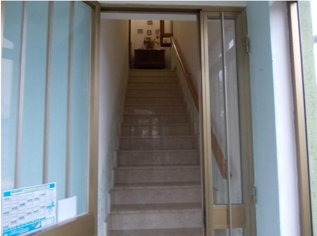
Foto 17 Scala accesso piano 1 da loggia
