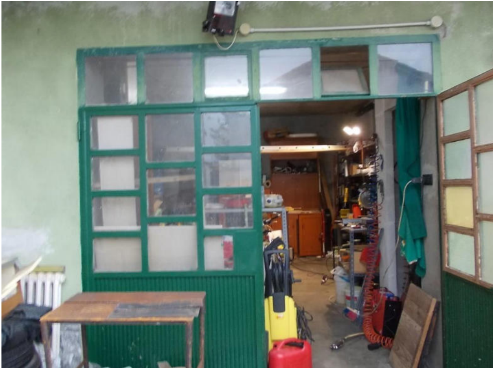
Foto 7 Portone ingresso garage sub.2 p.t.
