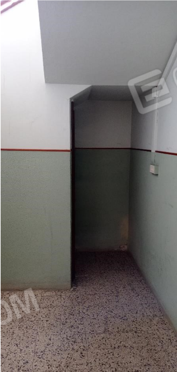
7. Accesso al piano cantine
