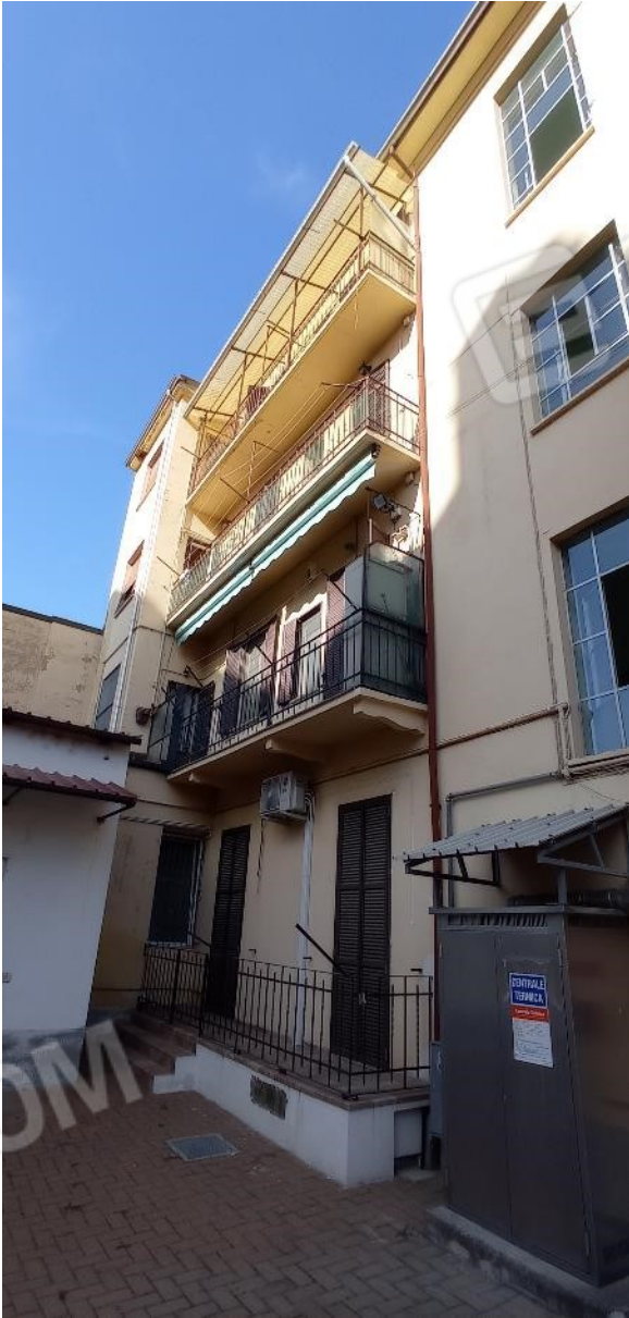
3. Prospetto interno cortile
