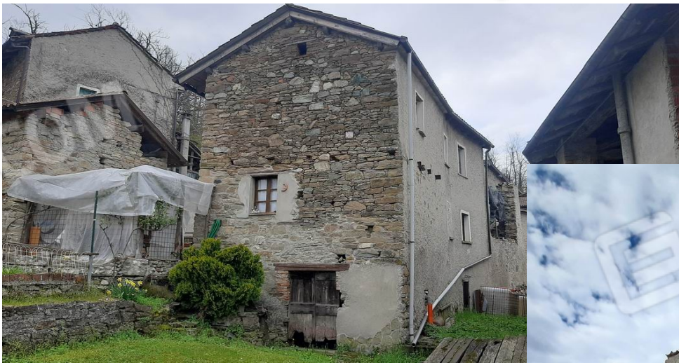
la testata nord
