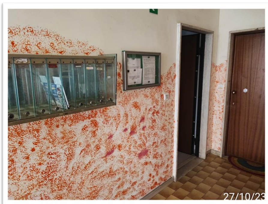
Ingresso Appartamento PT
