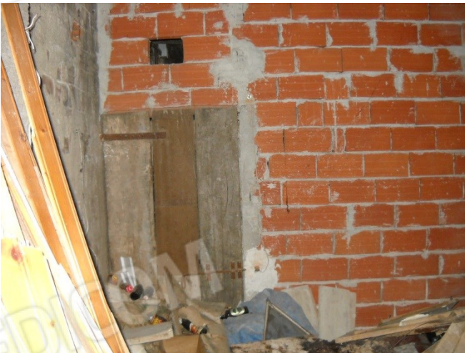
Locale cantina in piano seminterrato (sub.40)
