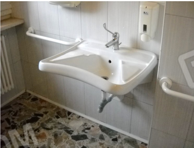
Locale commerciale servizi clienti (sub.34)
