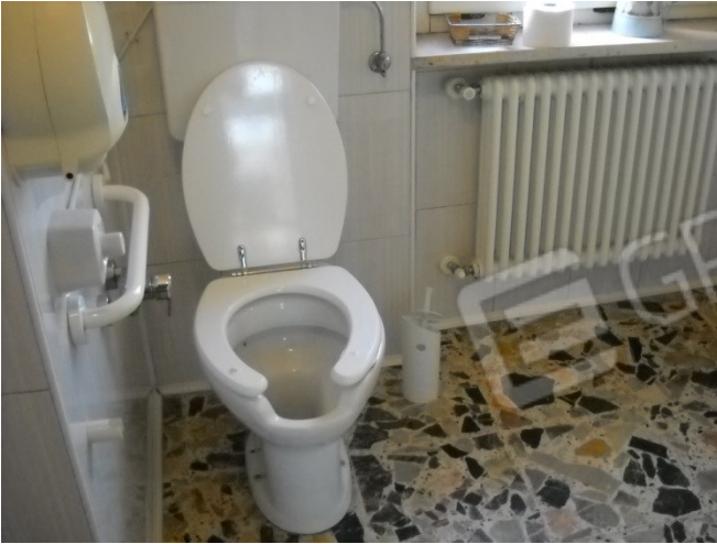
Locale commerciale servizi clienti (sub.34)
